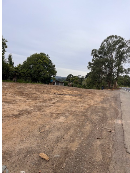
Foto 1: vista da via de acesso na BR 470, que dá acesso a estrada municipal cominho ao imóvel.
