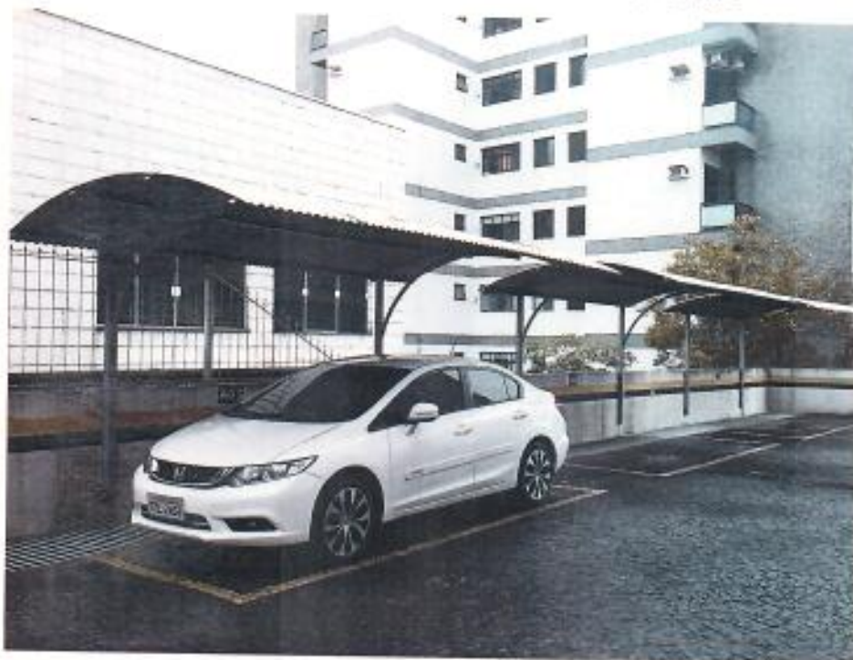
FOTO Nº 16) VISTA DE UMA DAS VAGAS DE GARAGEM NO TÉRREO
