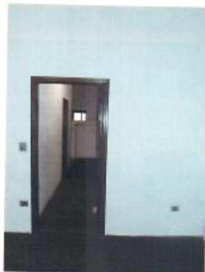
FOTO Nº 6) VISTA DO CORREDOR INTERNO
