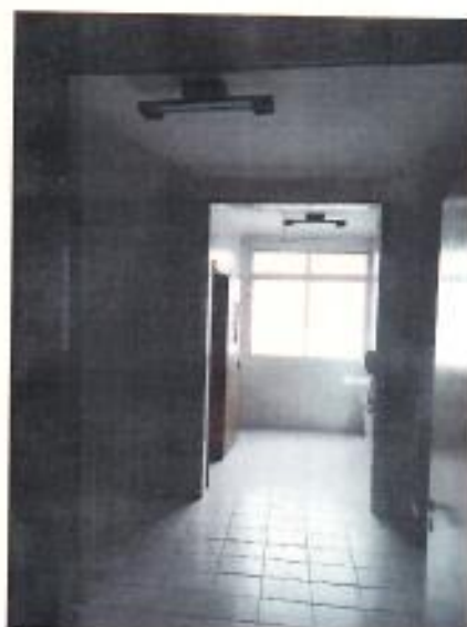
FOTO Nº 5) VISTA DA LAVANDERIA
