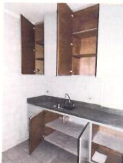
FOTO Nº 4) VISTA DA COZINHA DO APARTAMENTO.
