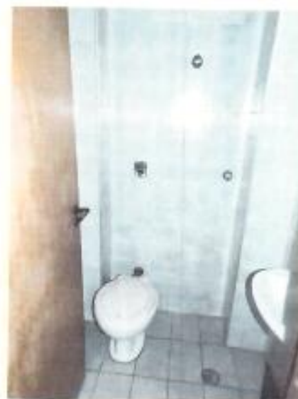
FOTO Nº 6) VISTA DO BANHEIRO DA ÁREA DE SERVIÇO.
