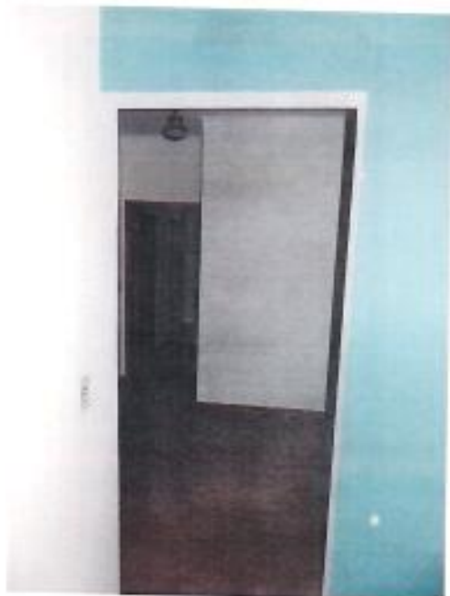
FOTO Nº 7) VISTA DO HALL DE ACESSO AOS DORMITÓRIOS
