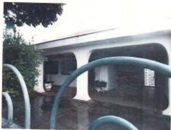
FOTO Nº 2) VISTA DA ÁREA DE ENTRADA COM JARDIM
