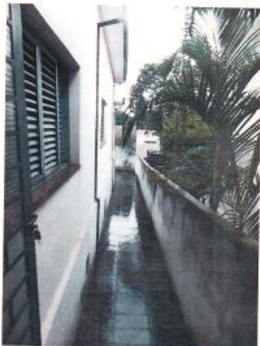
FOTO Nº 15) VISTA DO CORREDOR LATERAL EXTERNO
