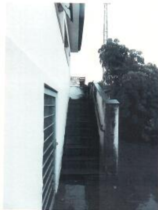
FOTO Nº 16) VISTA DO ACESSO DO QUINTAL A LAVANDERIA
