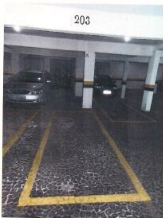
FOTO Nº 17) VISTA DA OUTRA VAGA DE GARAGEM NO SUBSÓLO
