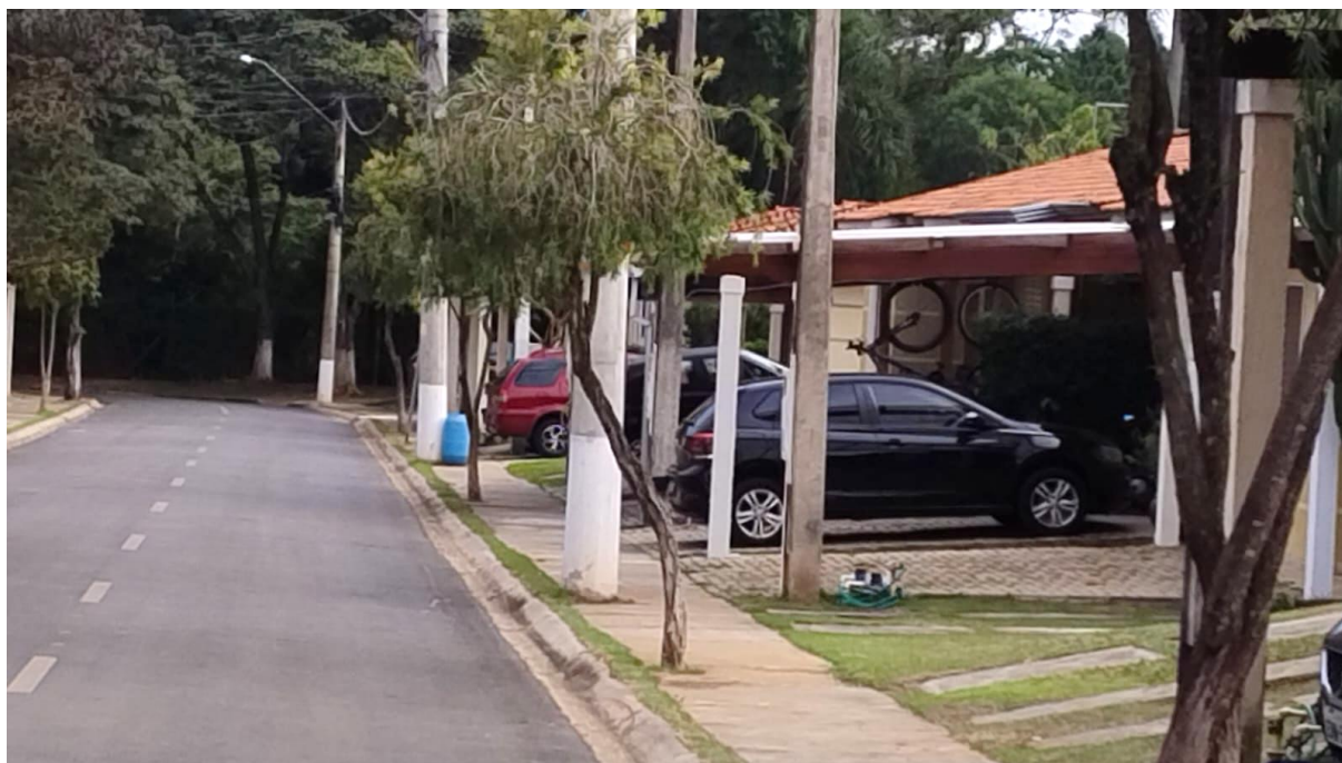
Vista da Via de acesso nº 3, frente ao imóvel avaliando
