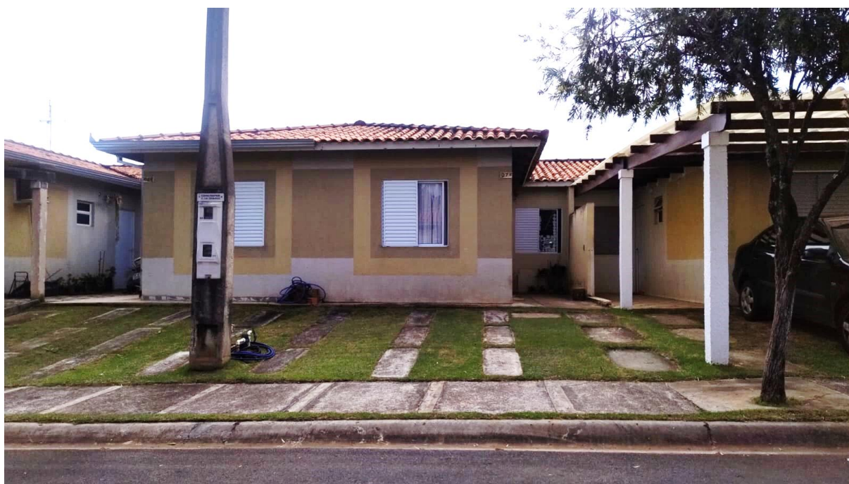
Vista da fachada do imóvel avaliando
