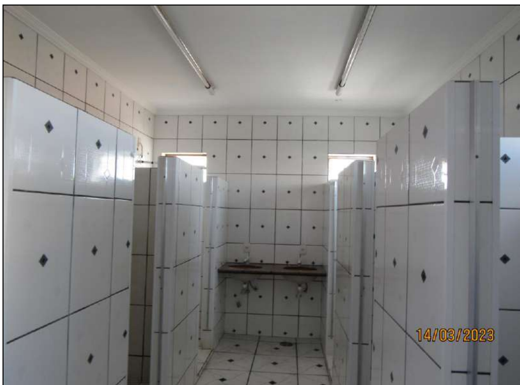
FOTO 30: Vista do banheiro coletivo no 2º pavimento do hotel.
