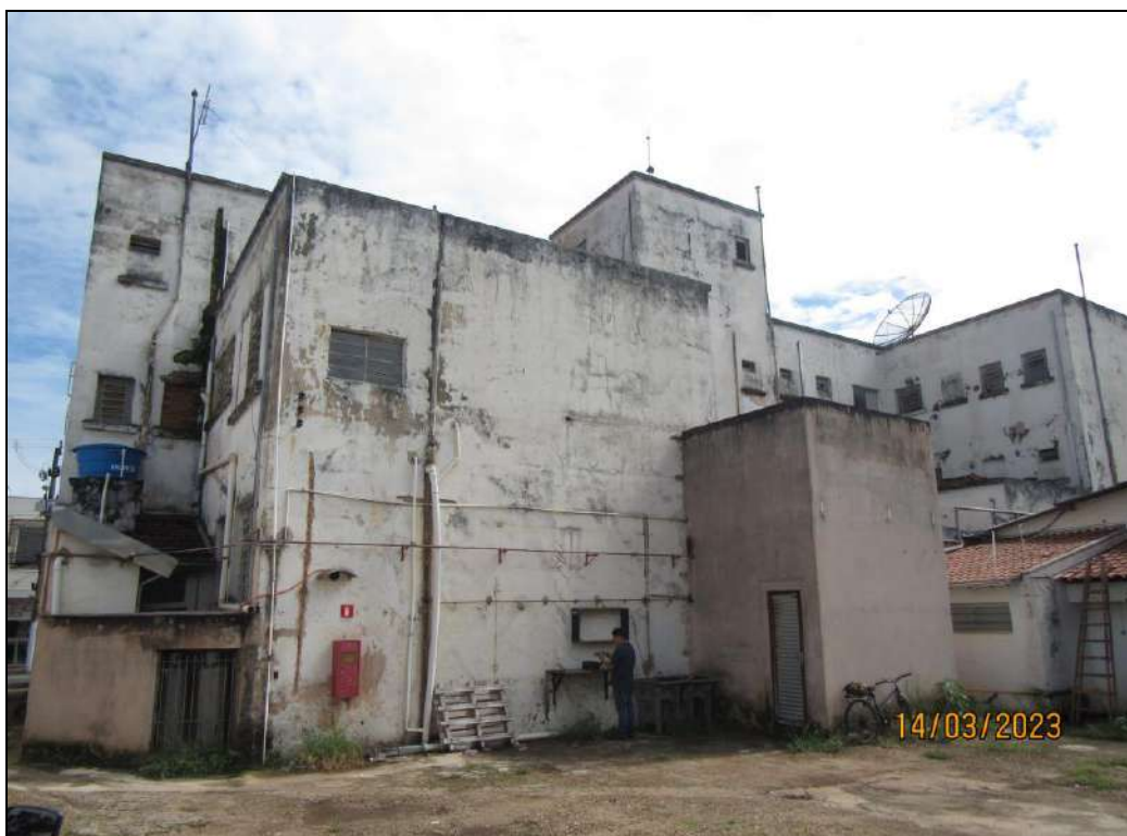
FOTO 23: Fundos do prédio.
