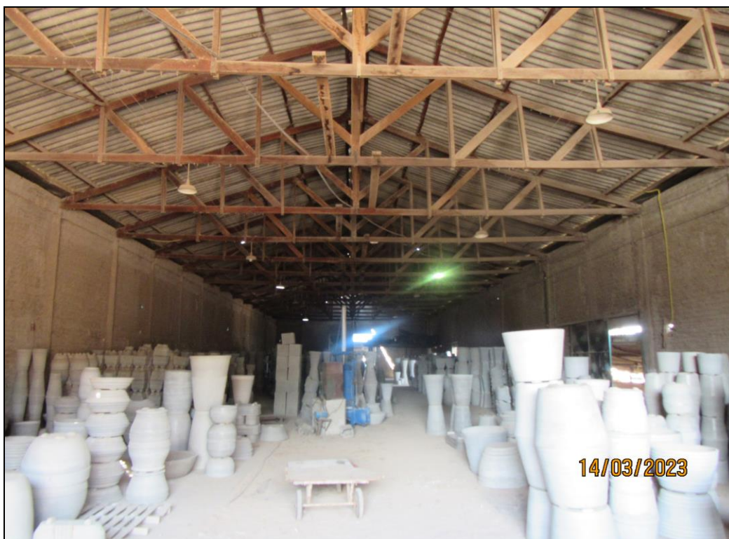
FOTO 06: Interior do barracão.
