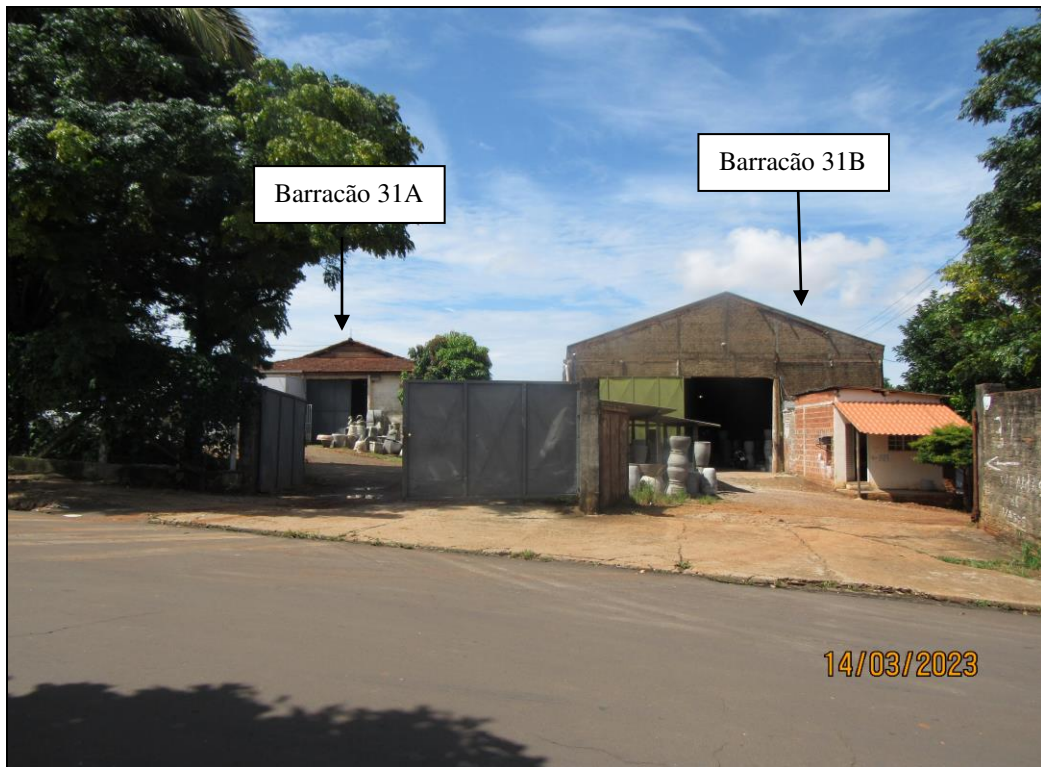
FOTO 01: Vista do imóvel pela Rua Vicente Crocci.
