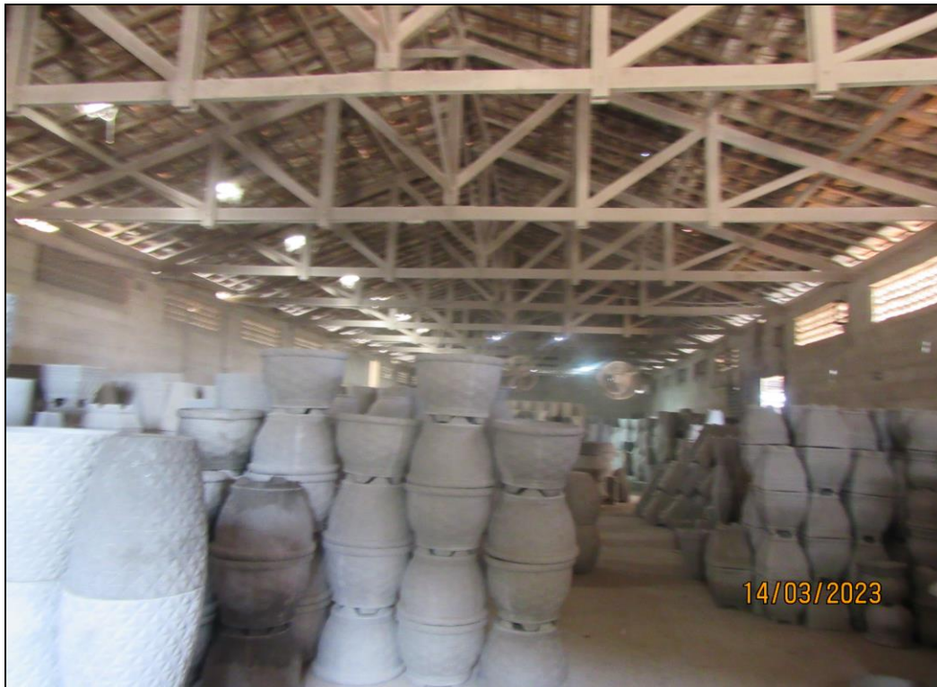
FOTO 11: Interior do barracão.
