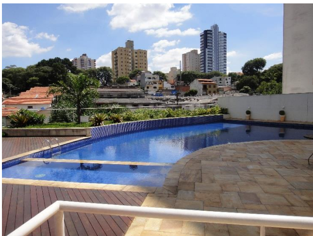
FOTO 13 – VISTA PARCIAL DA ÁREA DA PISCINA.
