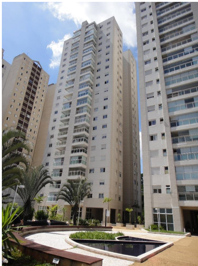
FOTO 12 – VISTA DO BLOCO 2.
