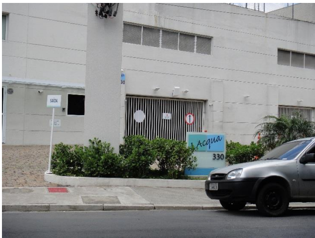
FOTO 3 – VISTA DA IDENTIFICAÇÃO DA NUMERAÇÃO DO CONDOMÍNIO E DA ÁREA DE ENTRADA PARA AS GARAGENS.
