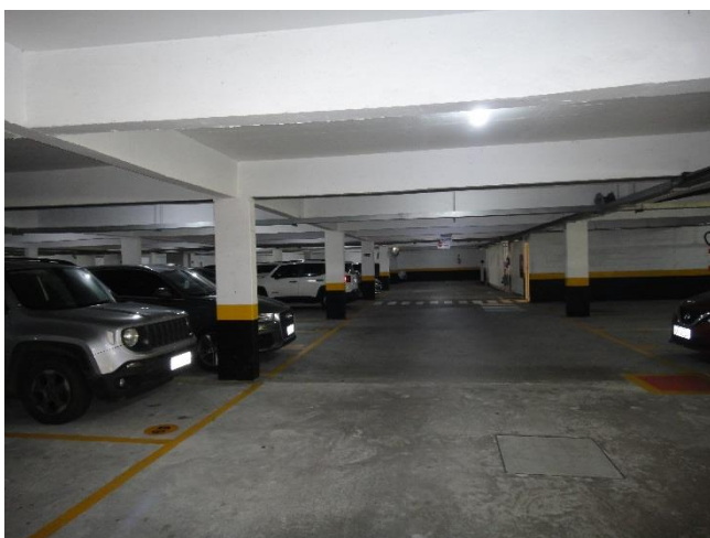
FOTO 21 – VISTA GERAL DA ÁREA DAS GARAGENS (1º OU 2º SUBRESOLOS).
