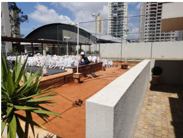
FOTO 9 – VISTA GERAL DO PAVIMENTO RECREATIVO, EM REFORMA.
