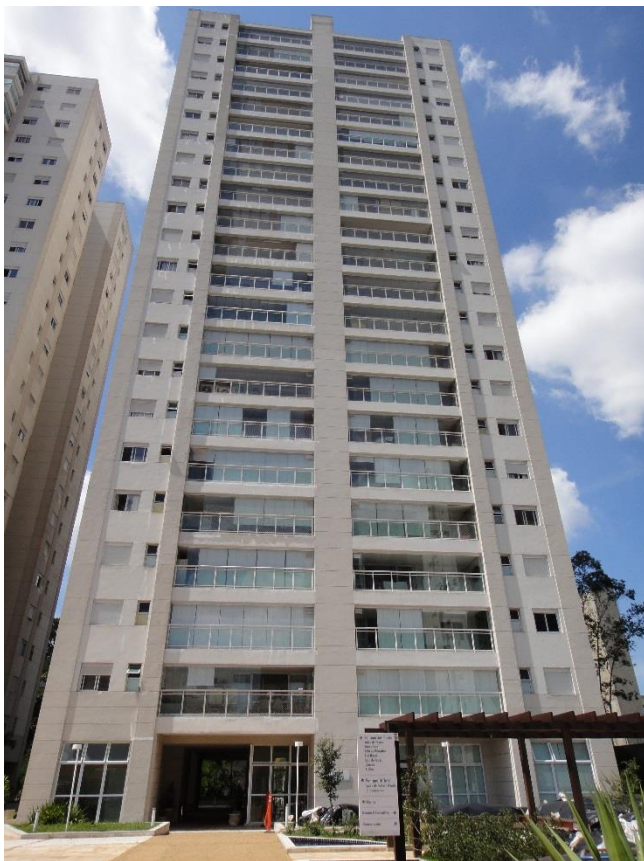
FOTO 11 – VISTA DO BLOCO 1.
