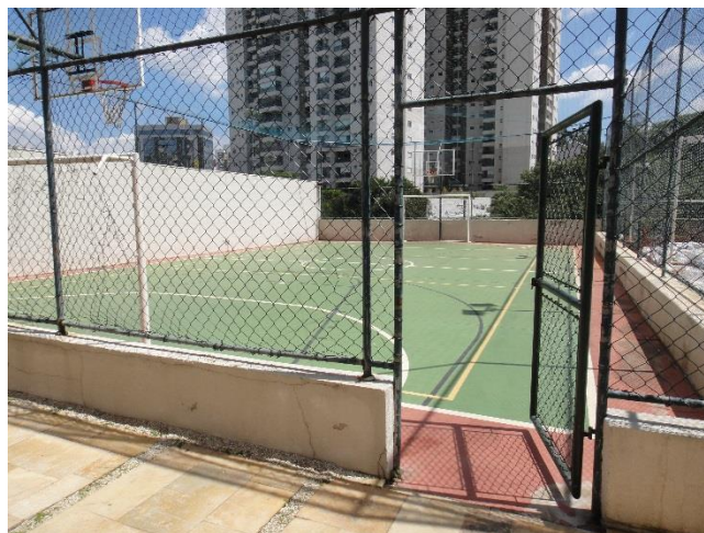
FOTO 20 – VISTA DA QUADRA POLIESPORTIVA.
