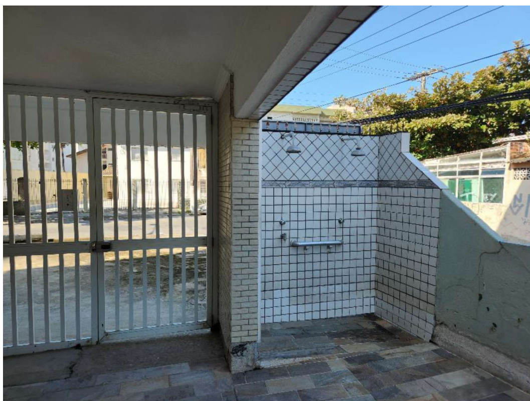
Área com chuveiro ao lado do portão de entrada de pedestres.
