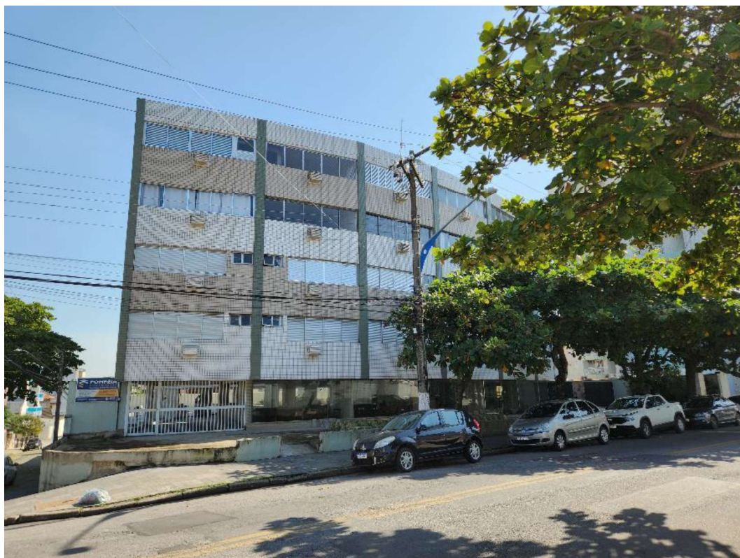
Fachada do edifício a partir da Est. Alexandre Miguez Rodrigues.
