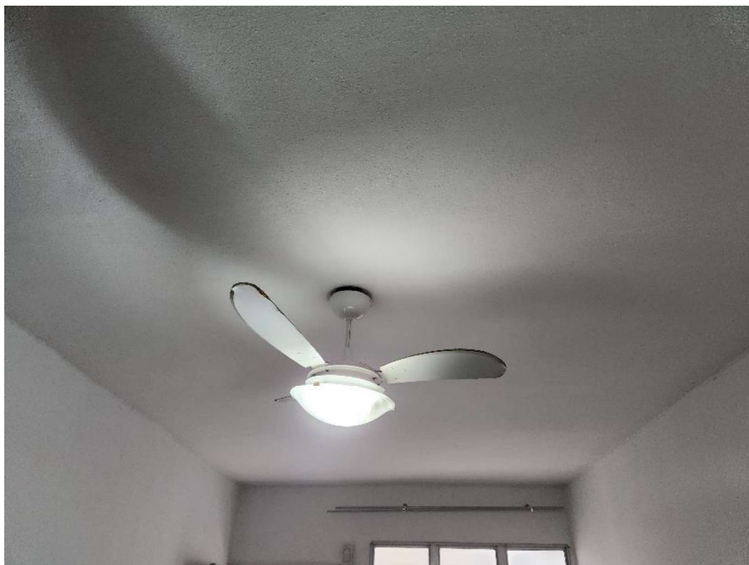
Teto com iluminação sobreposta.
