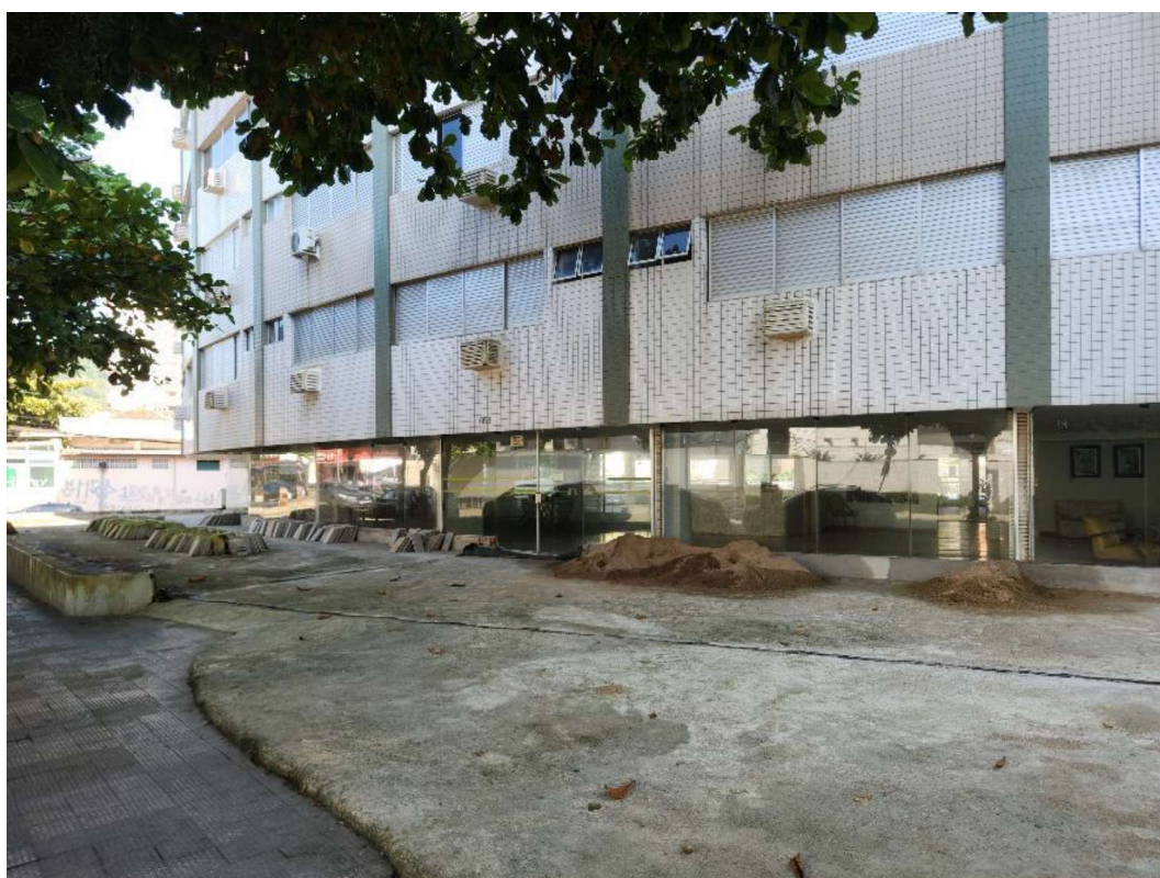
Pavimento térreo – em obras de reforma na data da vistoria pericial.
