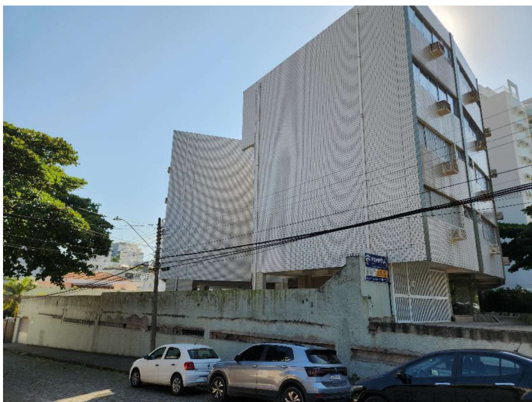
Fachada lateral da edificação.
