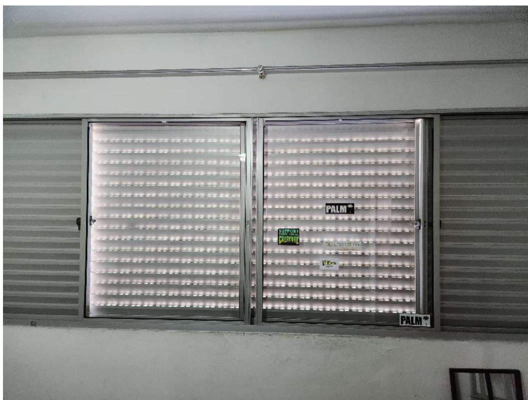
Caixilho em alumínio.
