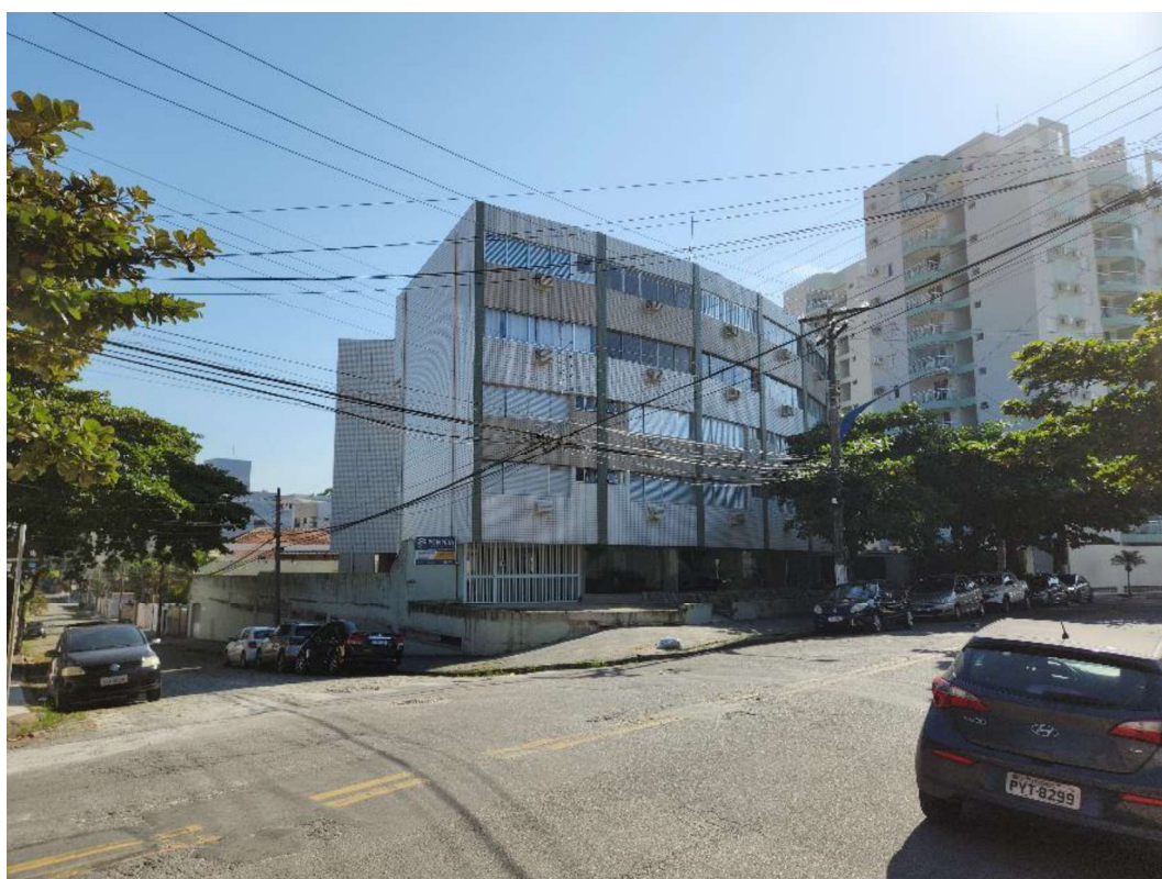
Mais uma vista da fachada do edifício – esquina entre a Est. Alexandre Miguez Rodrigues e Rua Francisco Messias
