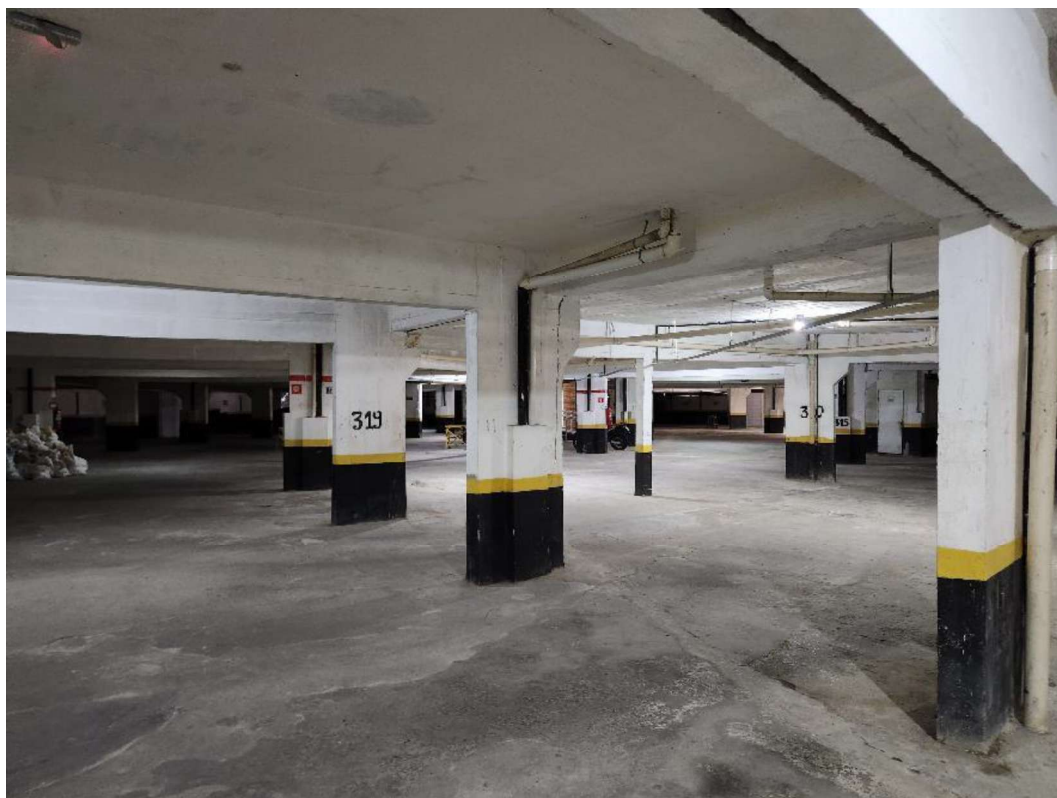
Visão geral do pavimento de garagem.
