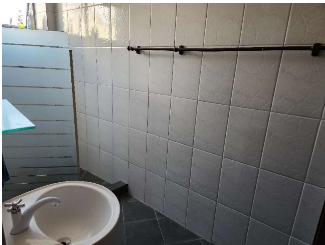
Banheiro que atende o apartamento.
