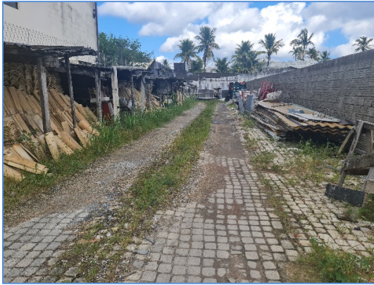
Foto 1 – Vista do lote avaliando, pavimentado e murado.
