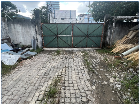
Foto 4 – Vista do portão metálico frontal
