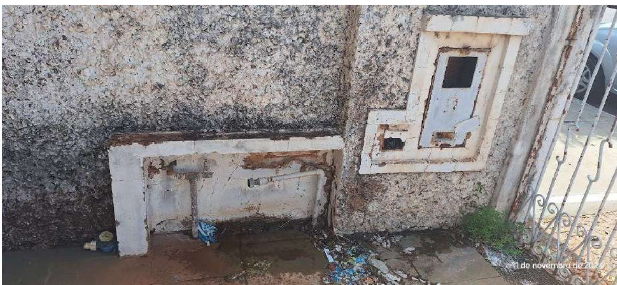
Entrada de Água e Energia Danificados
