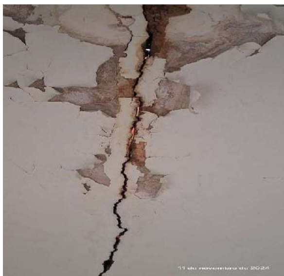
Det. Trinca laje - trinca vazada, visevel outro lado
