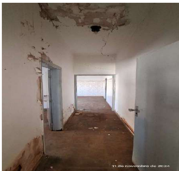
Corredor - Unidade e fissuras na laje
