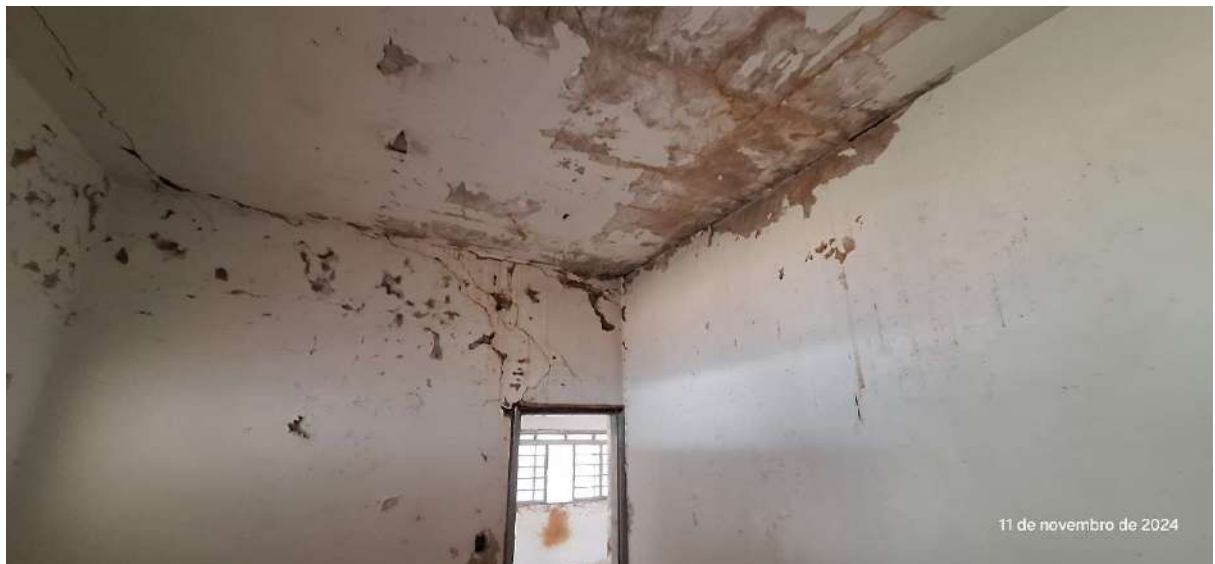
Sala 2 - Unidade vinda do Telhado, fissuras e trincas na estrutura
