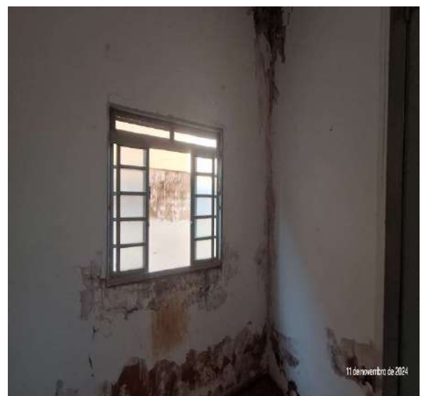
Escritório - Unidade vinda pela parede e teto
