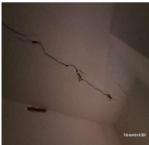
Trinca Laje Suíte
