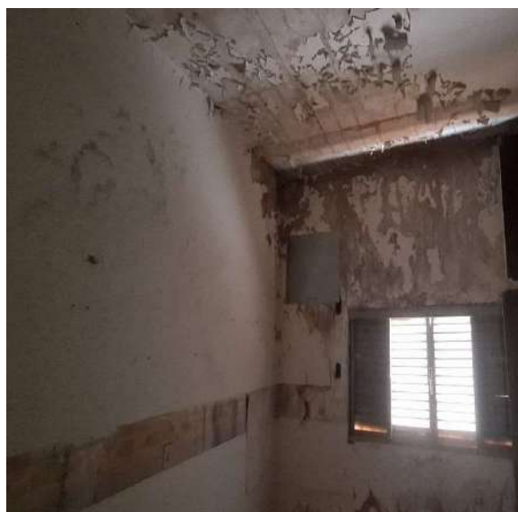
Quarto 2 - Umidade Vinda do Telhado
