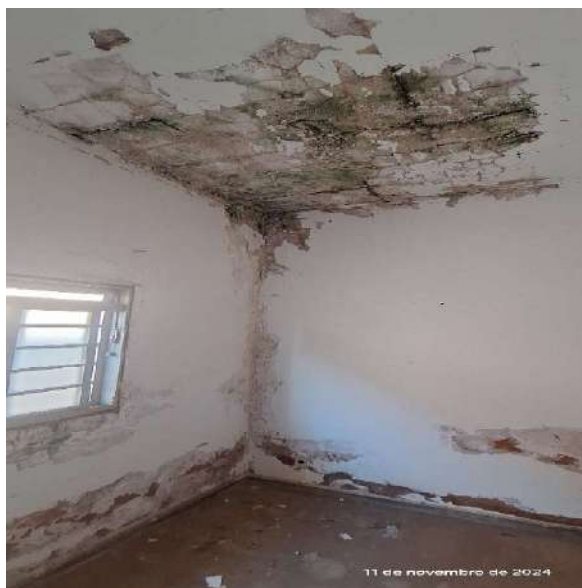
Escritório - Umidade vinda do telhado
