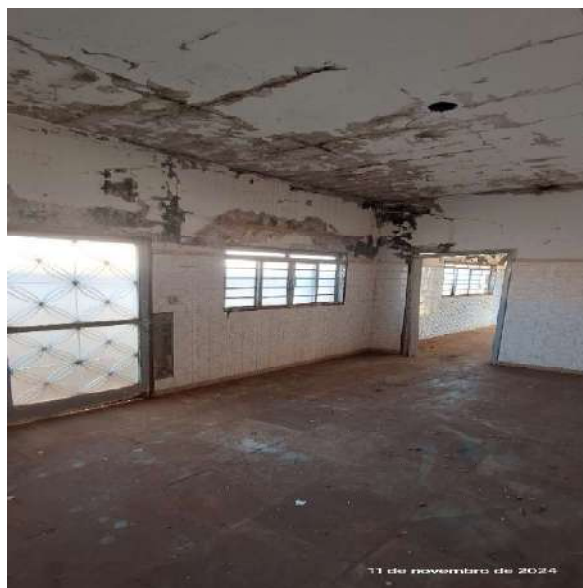
Copa - Umidade vinda do telhado
