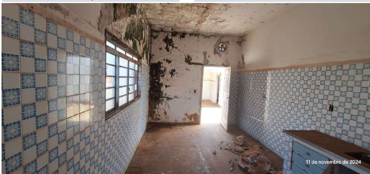
Cozinha - Umidade Vinda do Telhado
