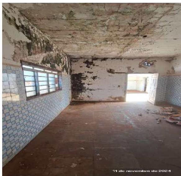
Cozinha - Detalhe Umidade vinda do telhado
