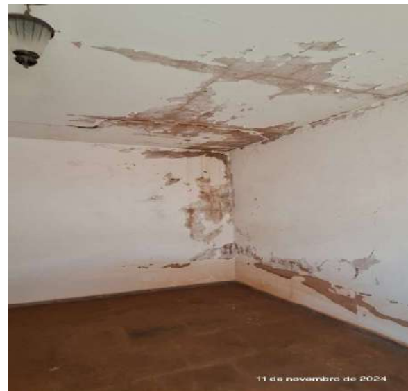
Quarto 3 - Umidade Vinda do Telhado
