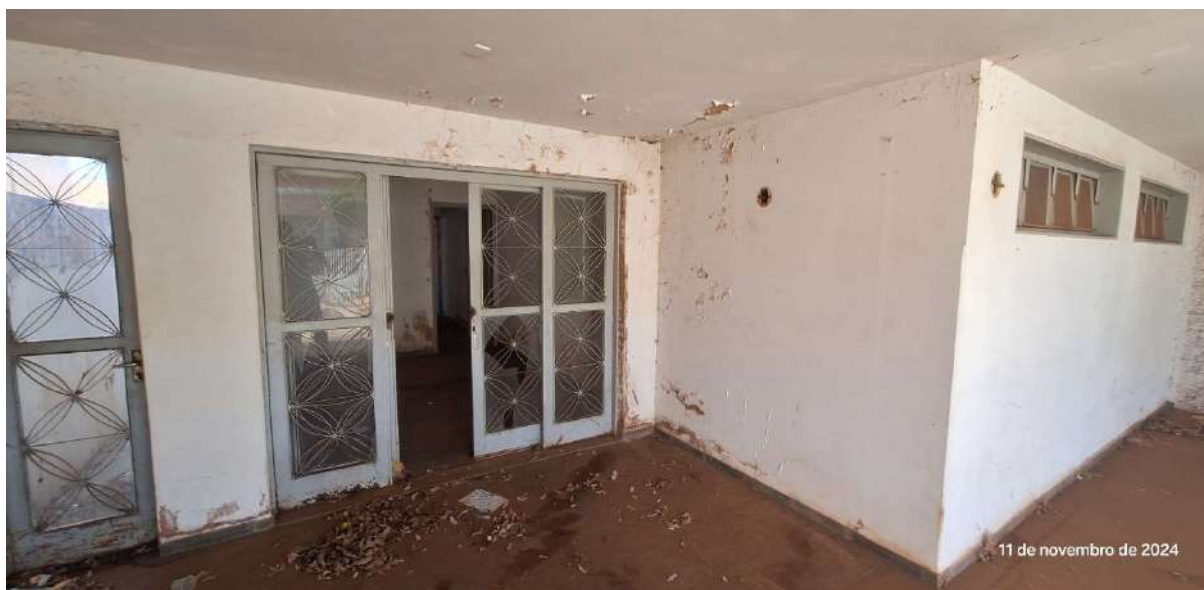
Entrada do imóvel e garagem - apresentando pontos de infiltração do telhado
