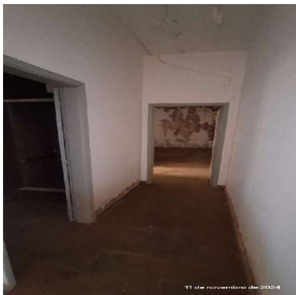
Corredor Quartos - Fissura e trinca
