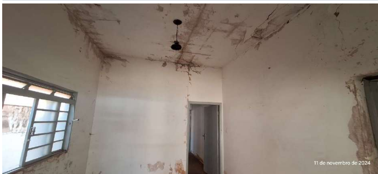
Laje da Sala com sinais de unidade vindo do telhado
