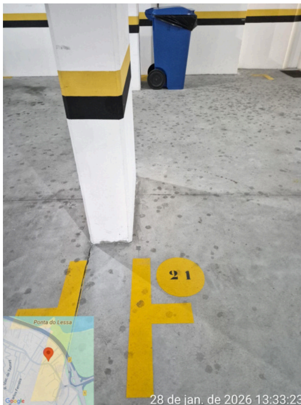
Foto 10: Vista da identificação numérica da vaga
