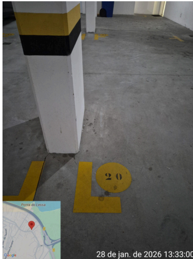
Foto 09: Vista da identificação numérica da vaga
