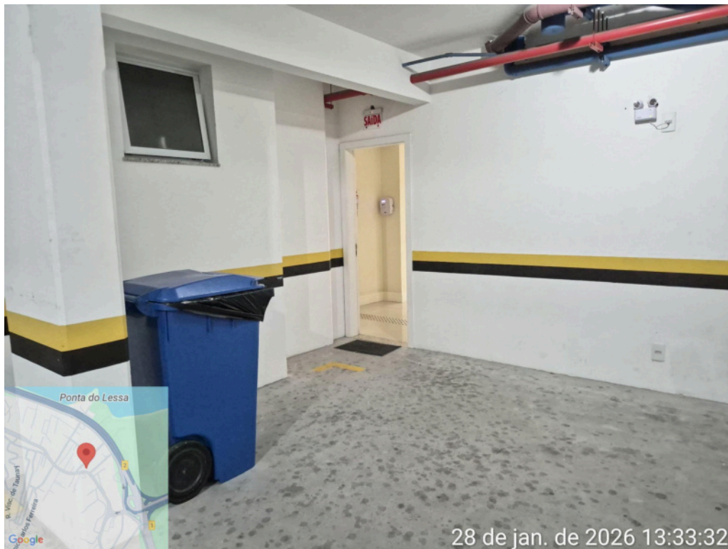
Foto 08: Vista voltada para a porta de acesso a recepção do edifício.
