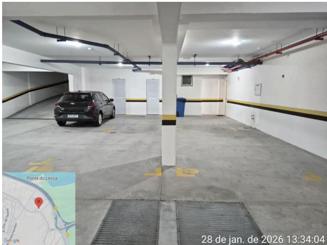
Foto 11: Vista da delimitação com a vaga dupla vizinha e pilares estruturais
