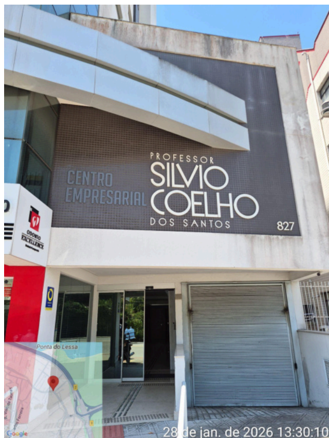
Foto 04: Vista do acesso de pedestre à recepção do edifício comercial.
