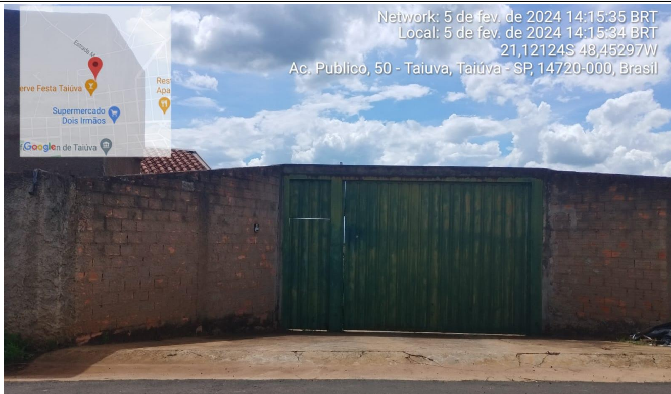
Imagem 01 – Fachada do Imóvel Avaliando.
