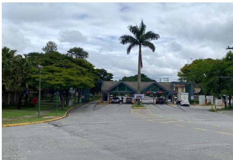
Foto da entrada do condomínio
