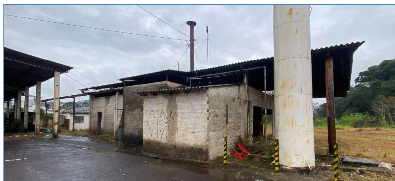
Figura 11 Casa da Caldeira e Oficina Fonte: O Perito
