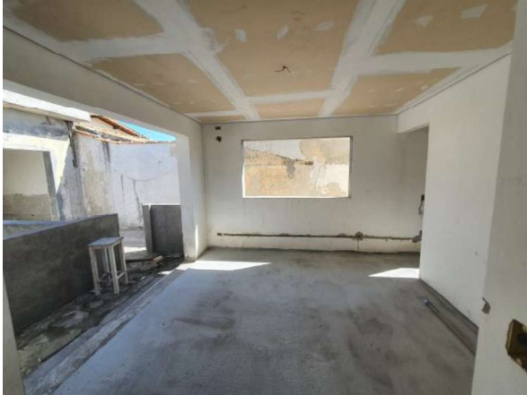
Casa em reforma
