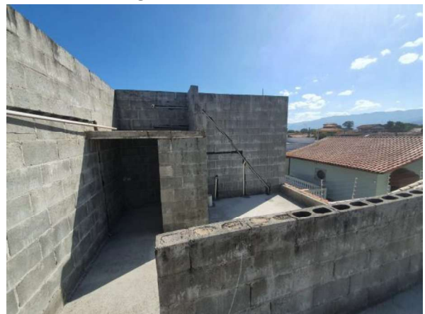
Casa em reforma
