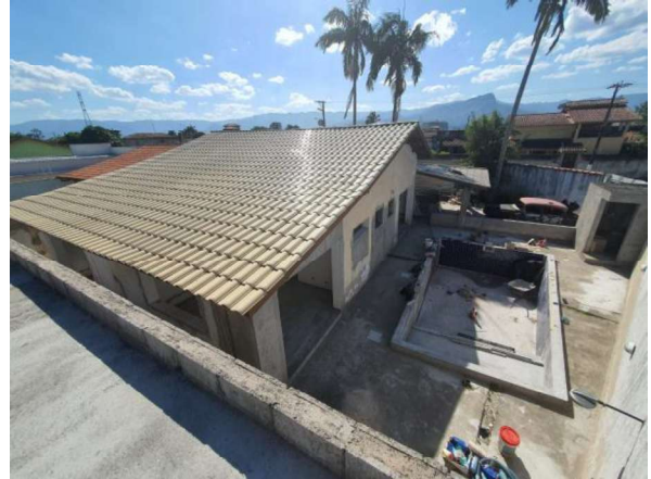
Casa em reforma
