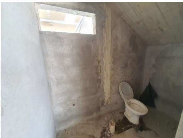
Casa em reforma
