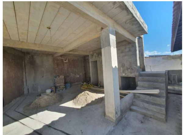
Casa em reforma
