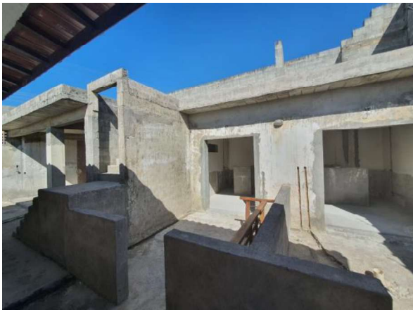
Casa em reforma
