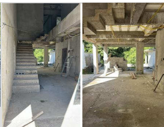
Vista da obra.
