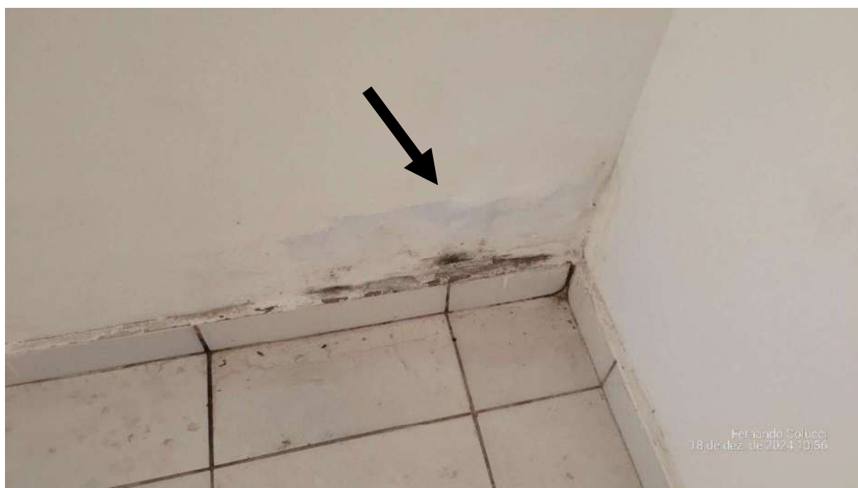
Figura 31 - Mancas de umidade no quarto 2, divisa com a parede do banheiro
