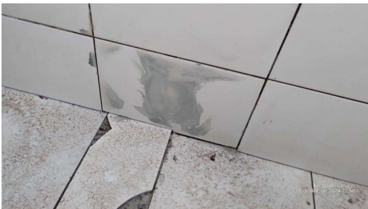
Figura 33 - Manchas de umidade em peças cerâmicas do banheiro
