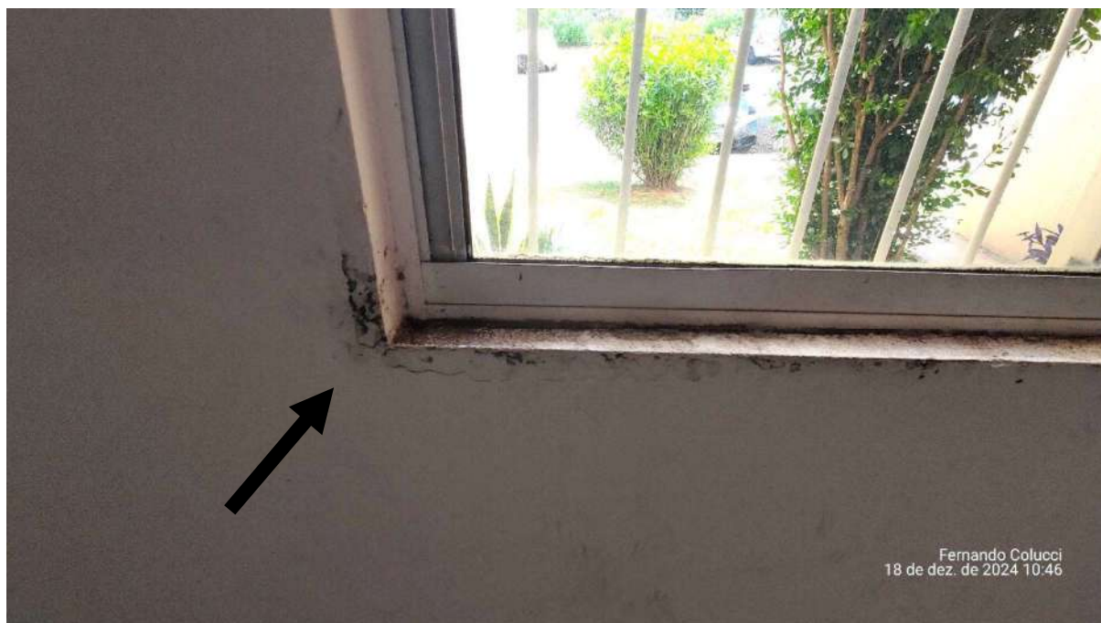
Figura 25 - Mancha de infiltração na esquadria do quarto
