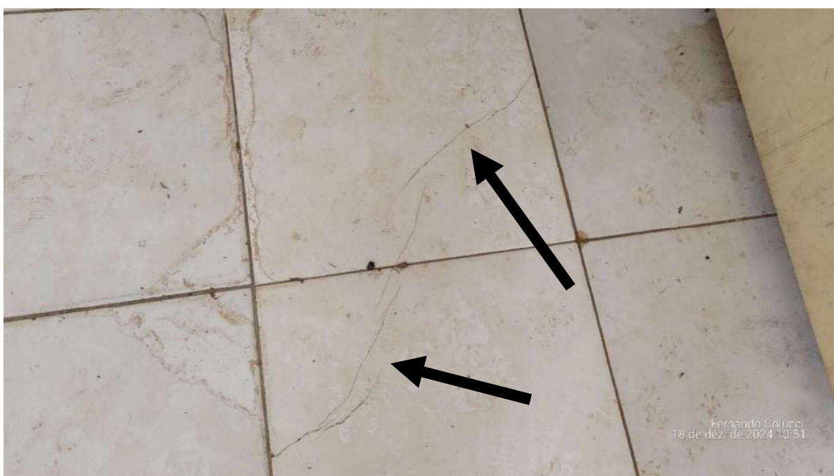
Figura 37 - Fissuração dos pisos da sala
