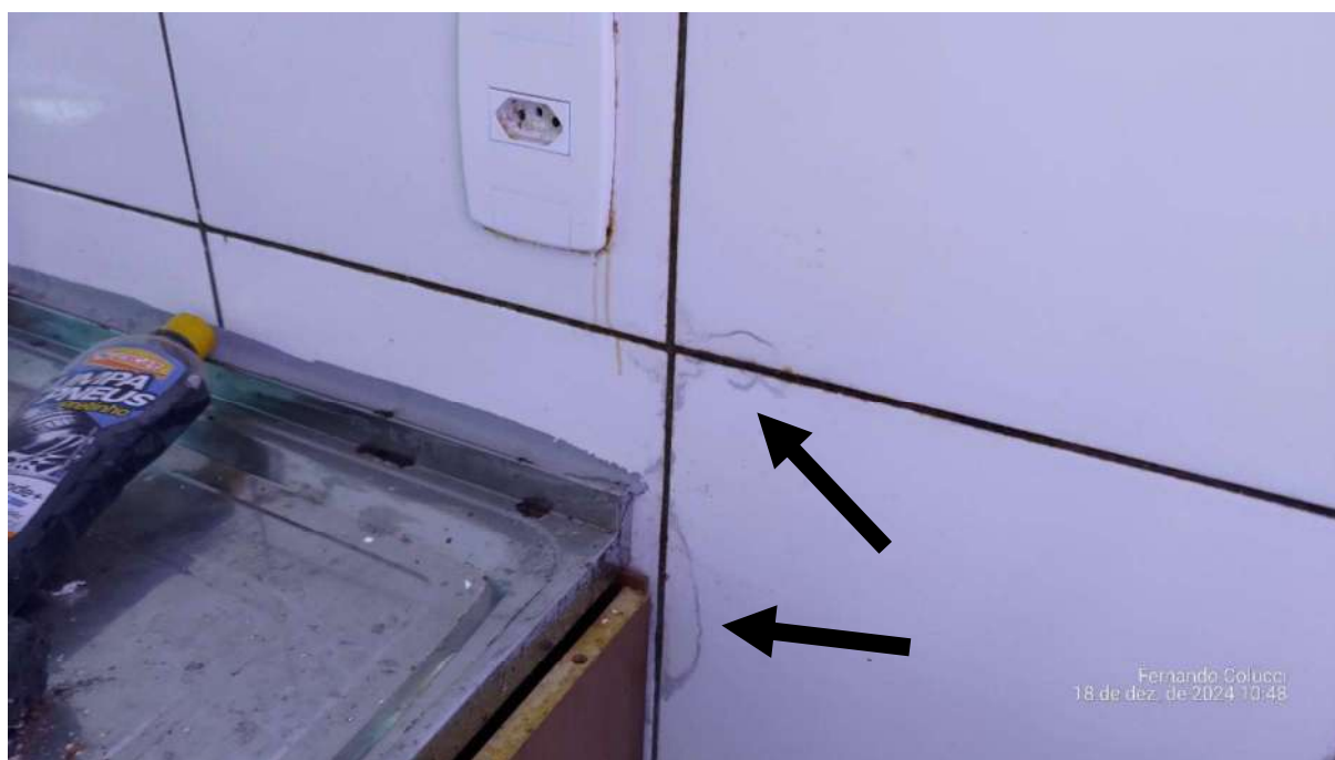
Figura 27 - Manchas de umidade em peças cerâmicas da cozinha
