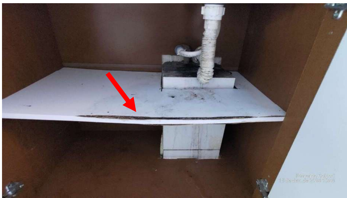
Figura 28 - Madeiramento estufado pelo excesso de umidade
