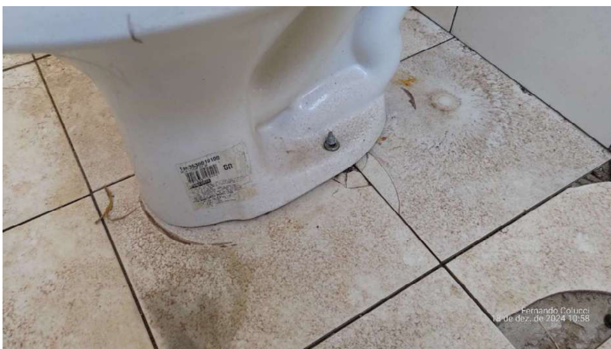
Figura 43 - Peças cerâmicas avariadas em volta do sanitário
