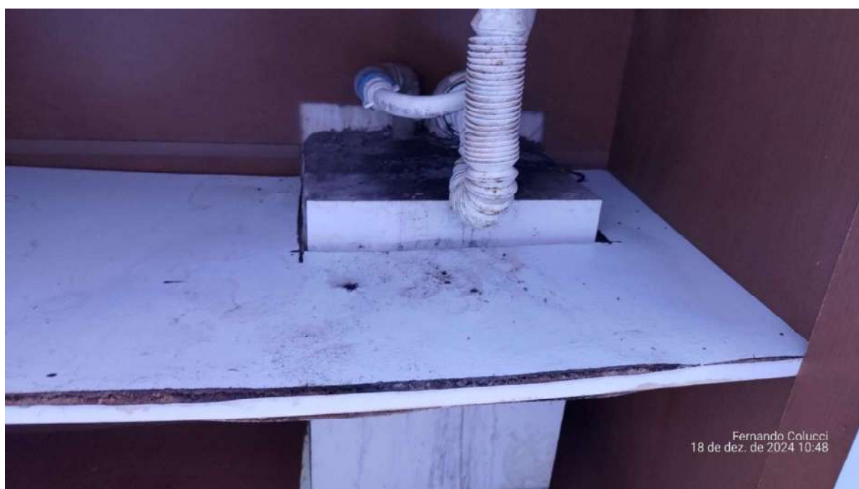
Figura 18 - Vazamento no sifão
