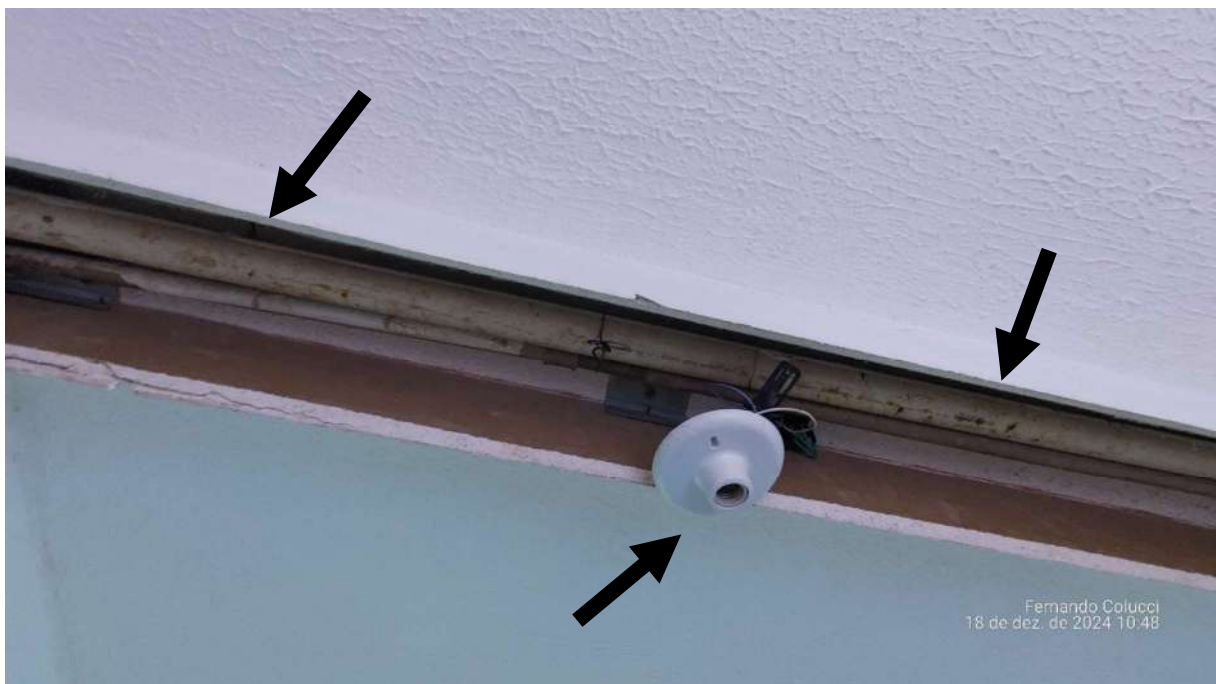
Figura 21 - Ausência de lâmpada na cozinha, queda do forro e exposição da fiação e encanamento
