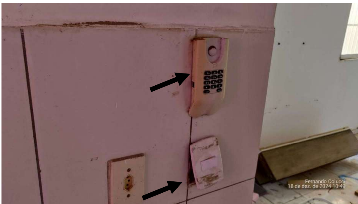
Figura 22 - Interfone quebrado e tomada avariada
