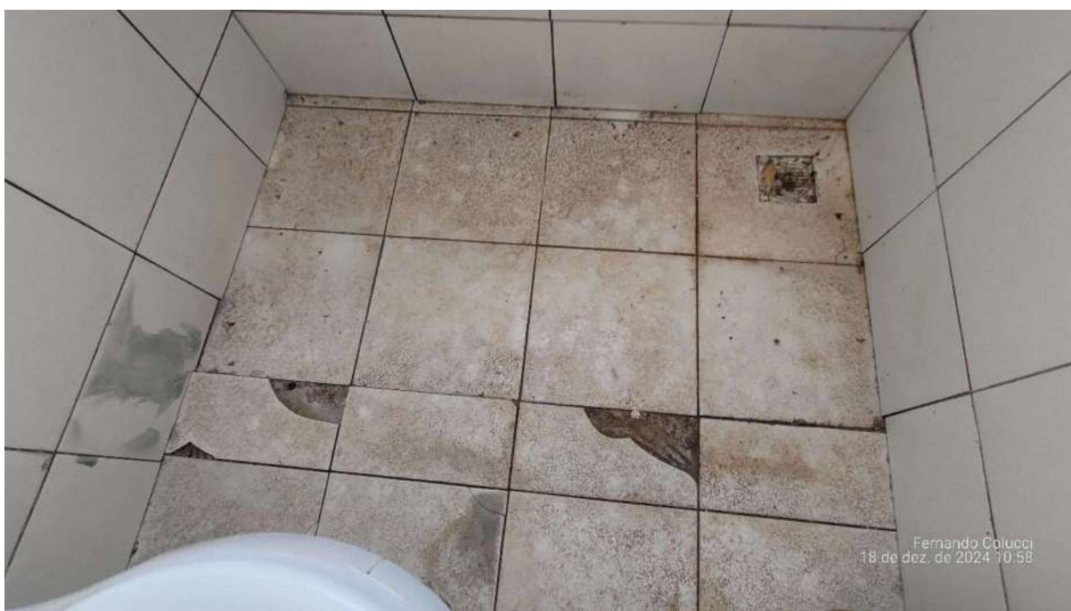
Figura 42 - Peças cerâmicas avariada no banheiro
