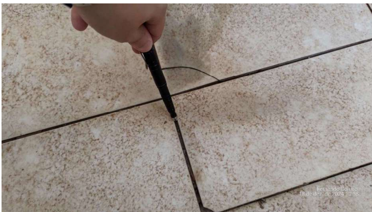
Figura 34 - Ausência de rejunte no piso do banheiro permitindo a percolação de água
