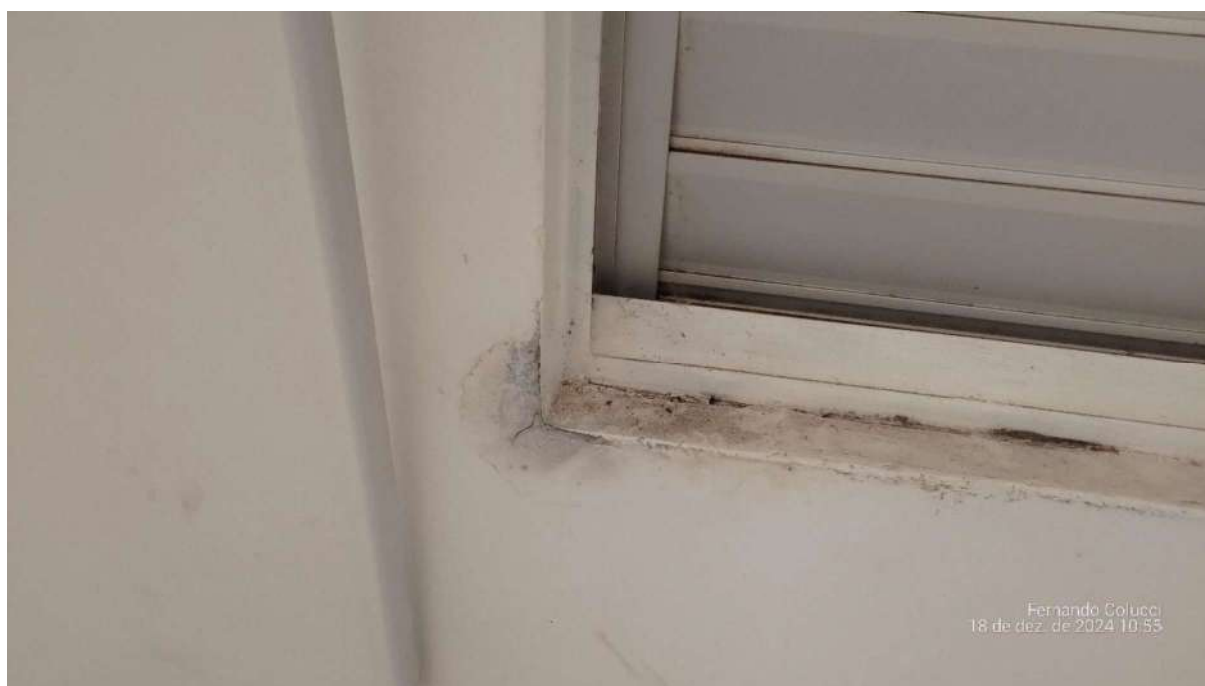
Figura 29 - Manchas de umidade no quarto 2
