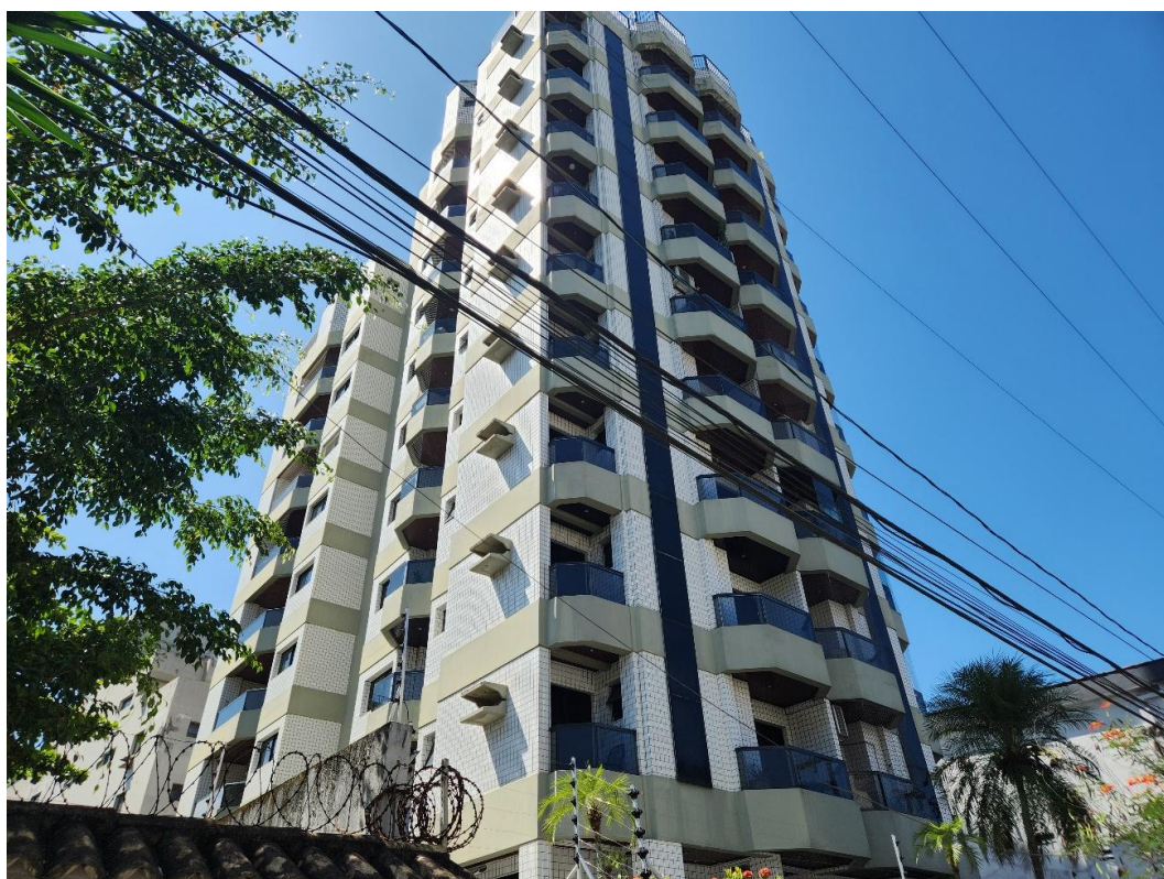
Fachada da edificação sob outro ângulo.
