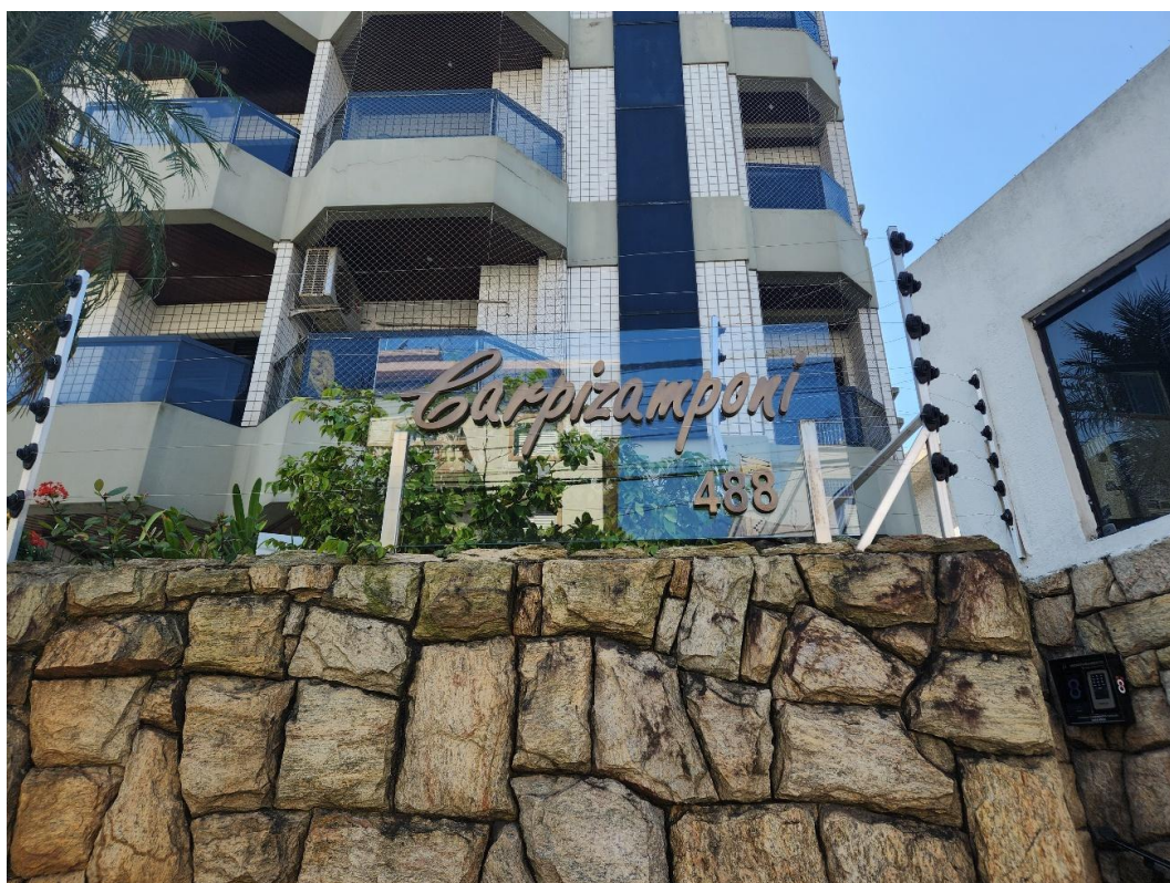
Placa de identificação do Condomínio.
