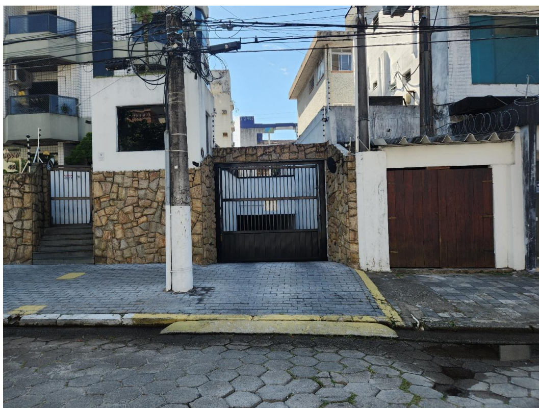
Acesso à garagem no pavimento subsolo em mais detalhes.
