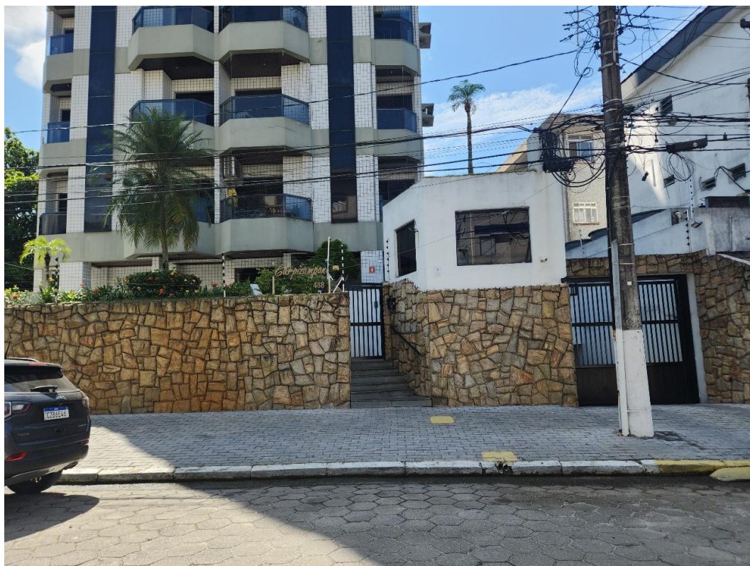
Entrada de pedestres ao centro da foto e portão da garagem à direita da foto.
