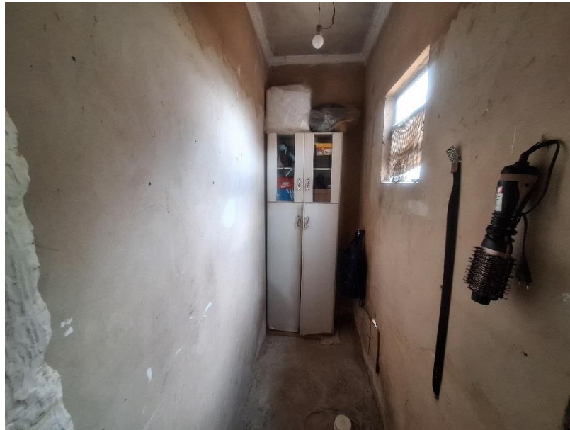
VISTA DO BANHO SUÍTE, NÃO POSSUI ACABAMENTOS.
