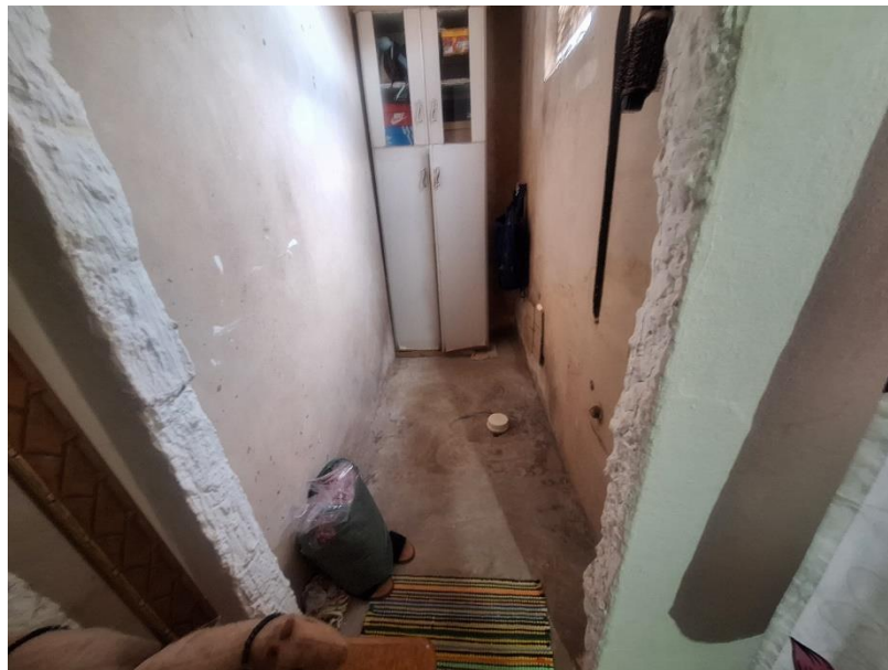
VISTA DO PISO DO BANHO SUÍTE, NÃO POSSUI ACABAMENTOS.
