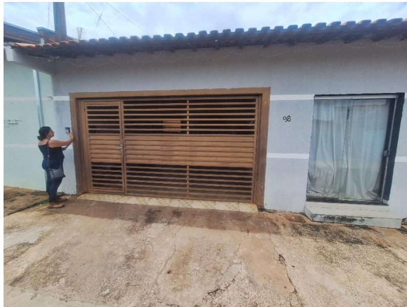
VISTA DO PORTÃO DE ACESSO AO IMÓVEL.
