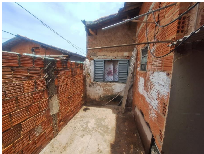
VISTA DO CORREDOR LATERAL EXTERNO.
