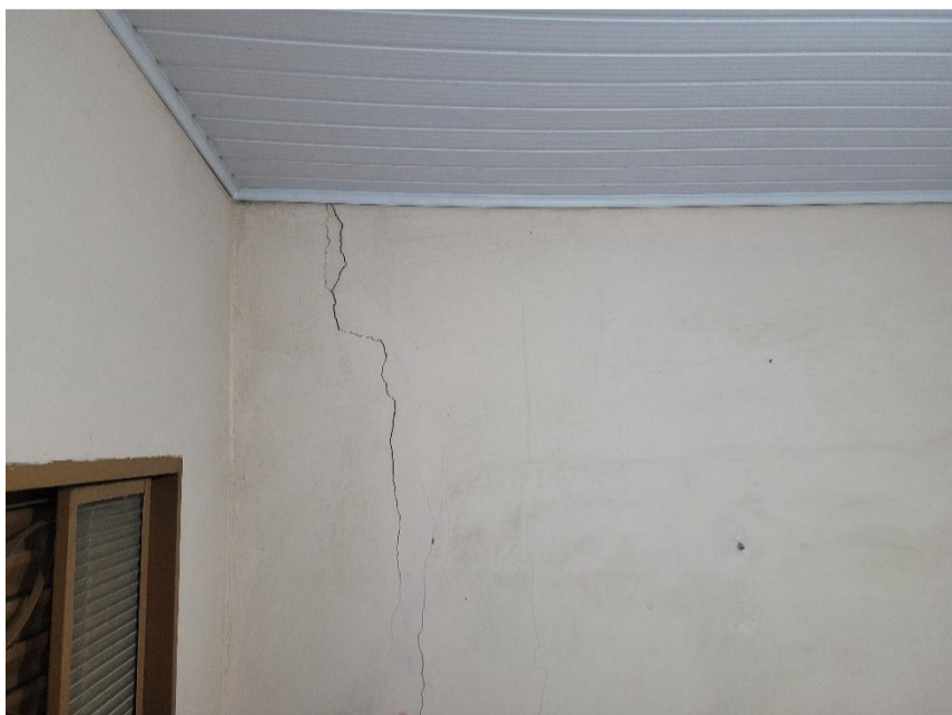
Foto 26 – trinca vertical
