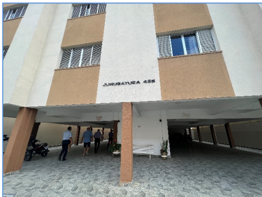
Foto 1 – Fachada frontal do edifício
