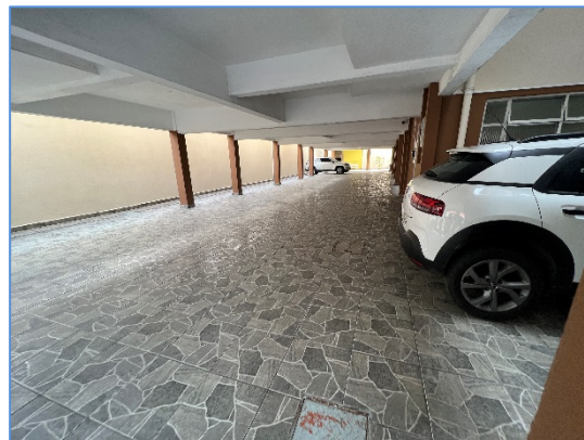
Foto 2 – Vista da área de garagem no térreo
