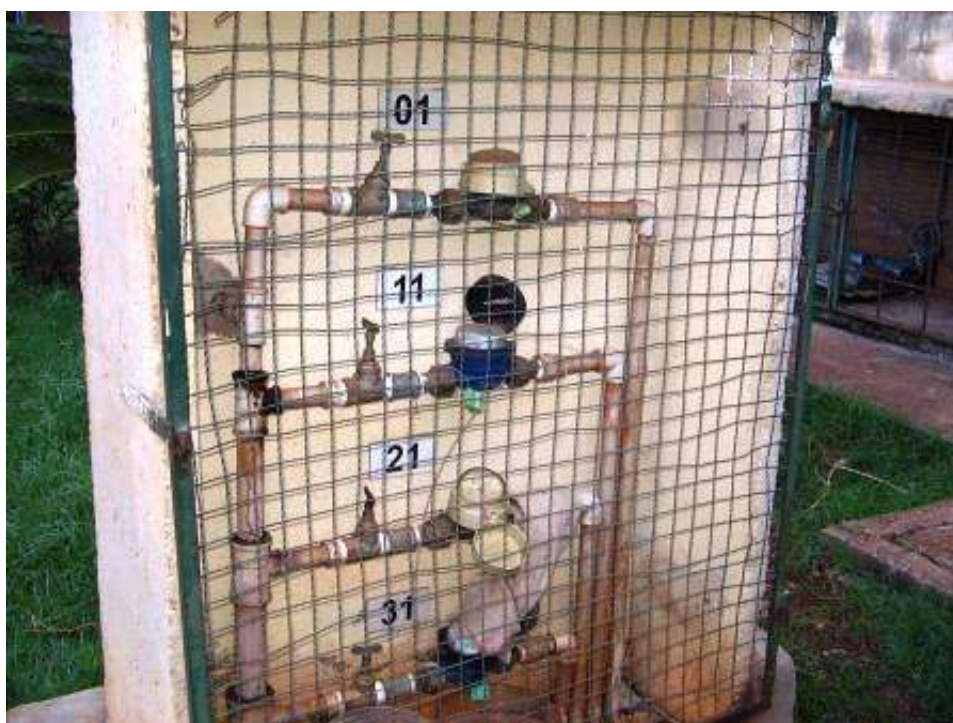
FOTO 4 Medidores individuais de água do Bloco 12 da Quadra 6.
