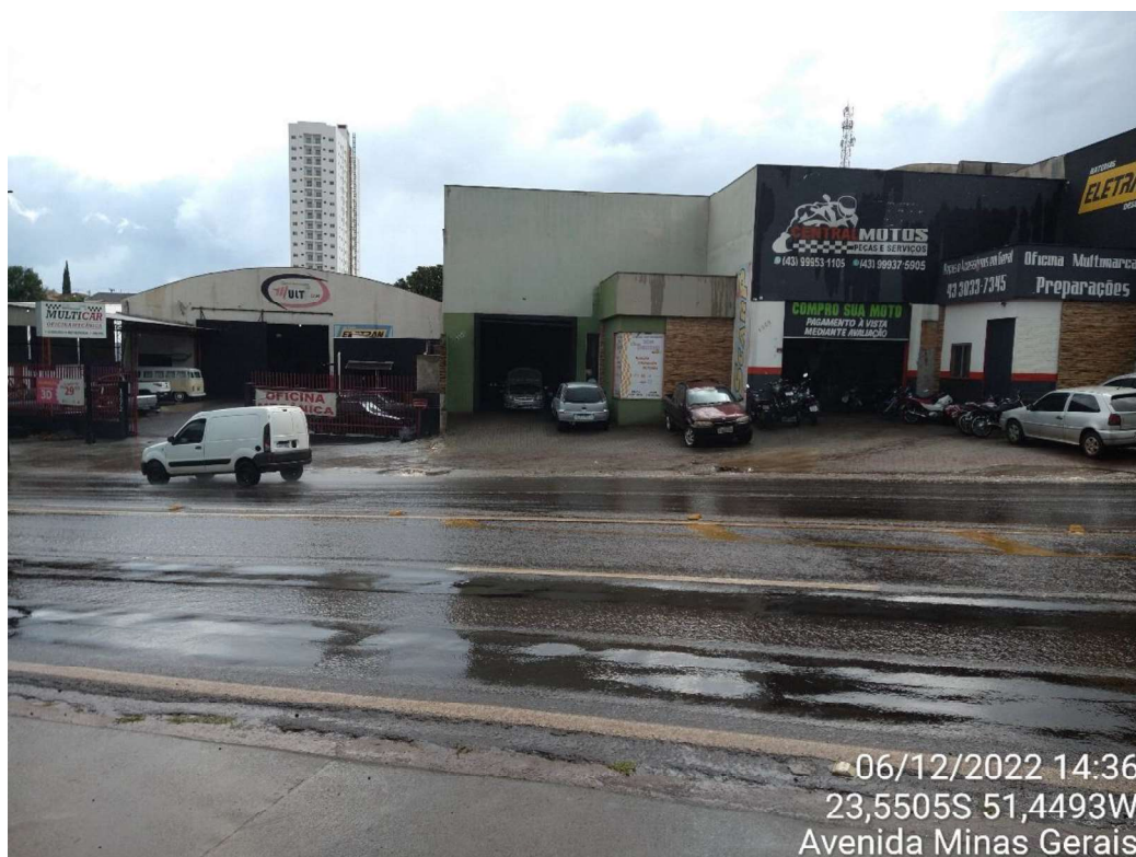
Vista frontal do imóvel.
