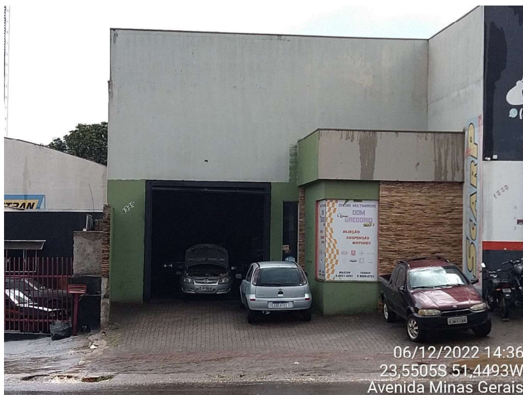
Vista frontal do imóvel.
