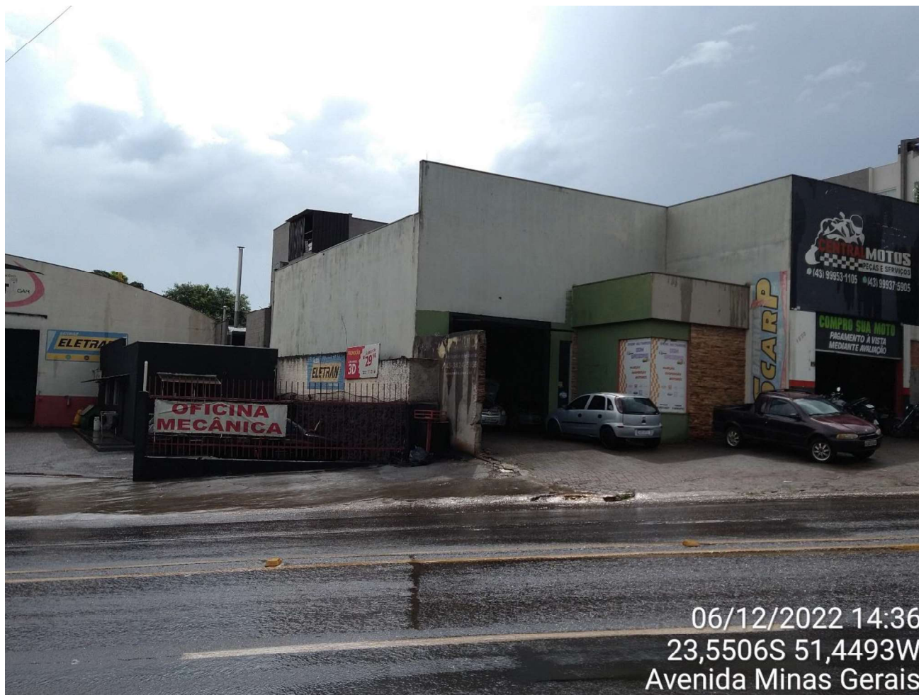
Vista lateral do imóvel.
