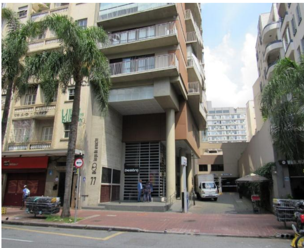
Foto 1 – Fachada do Edifício
