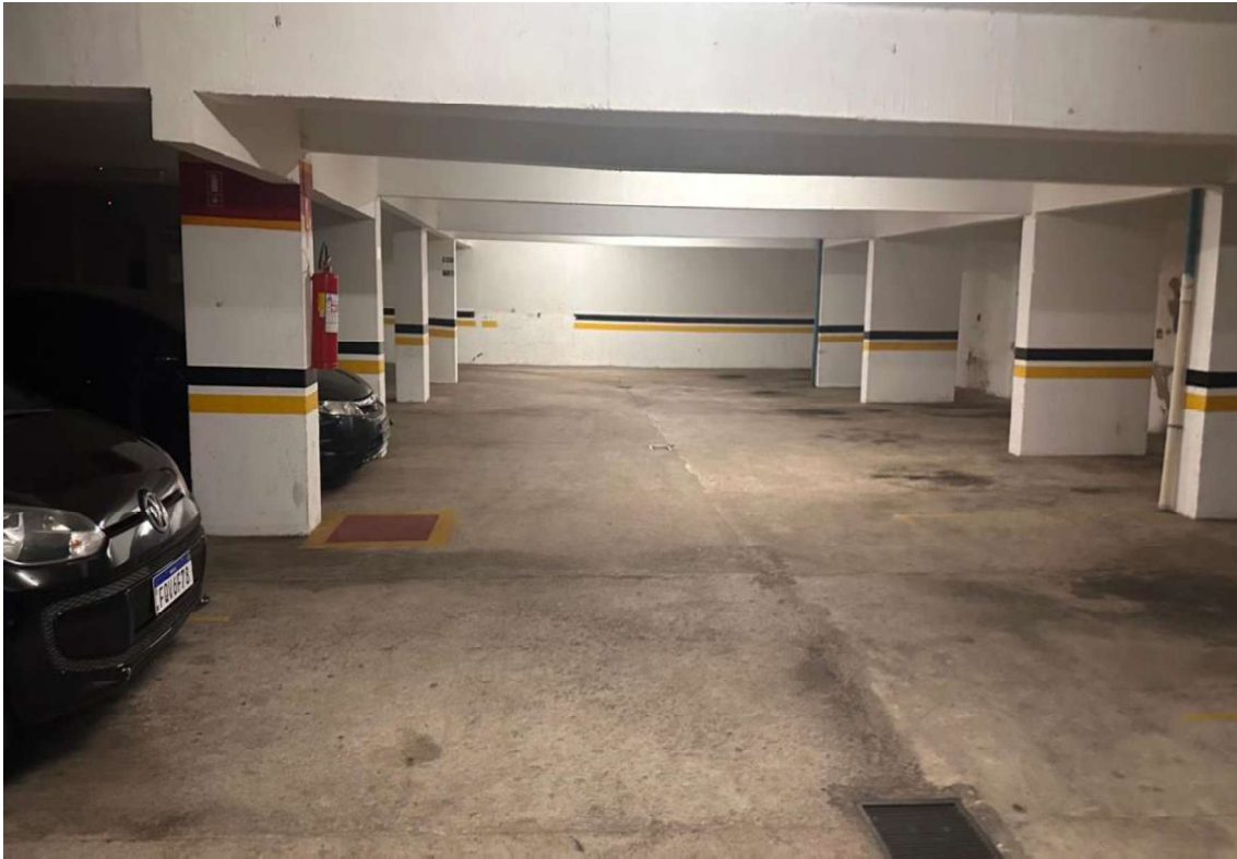
Visão interna da garagem subsolo II
