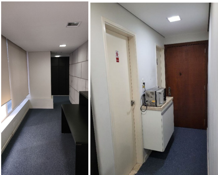
Vista parcial corredor de acesso aos sanitários do conjunto 42 – ao fundo, porta do pequeno espaço técnico da sala acústica
