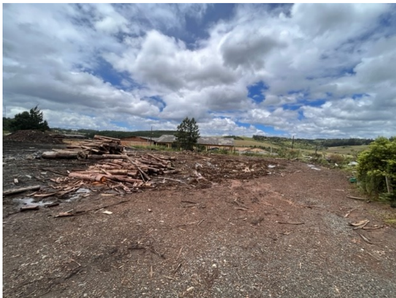
Foto 2: imagem do imóvel.
