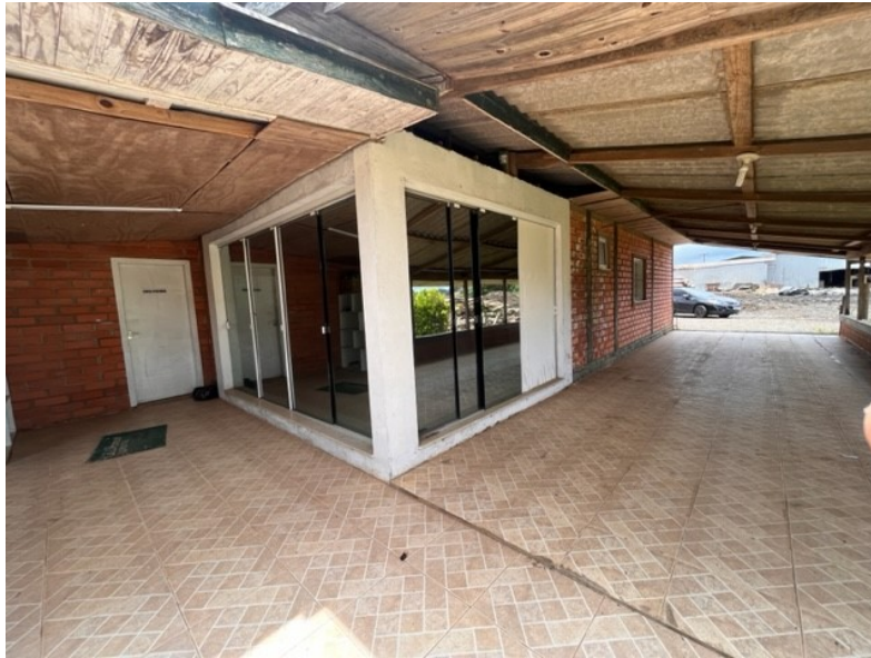
Foto 6: imagem edificação escritórios.
