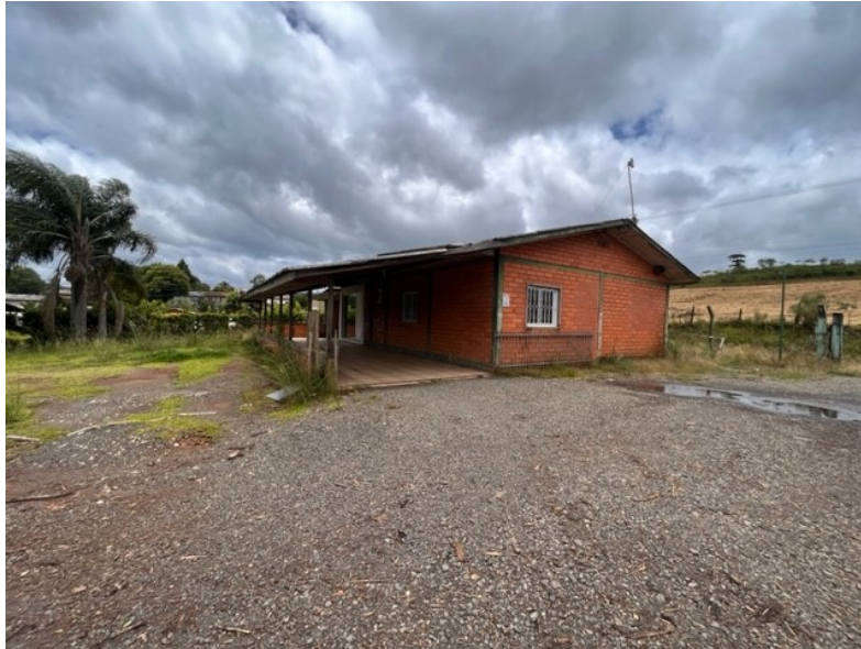
Foto 3: imagem edificação escritórios.
