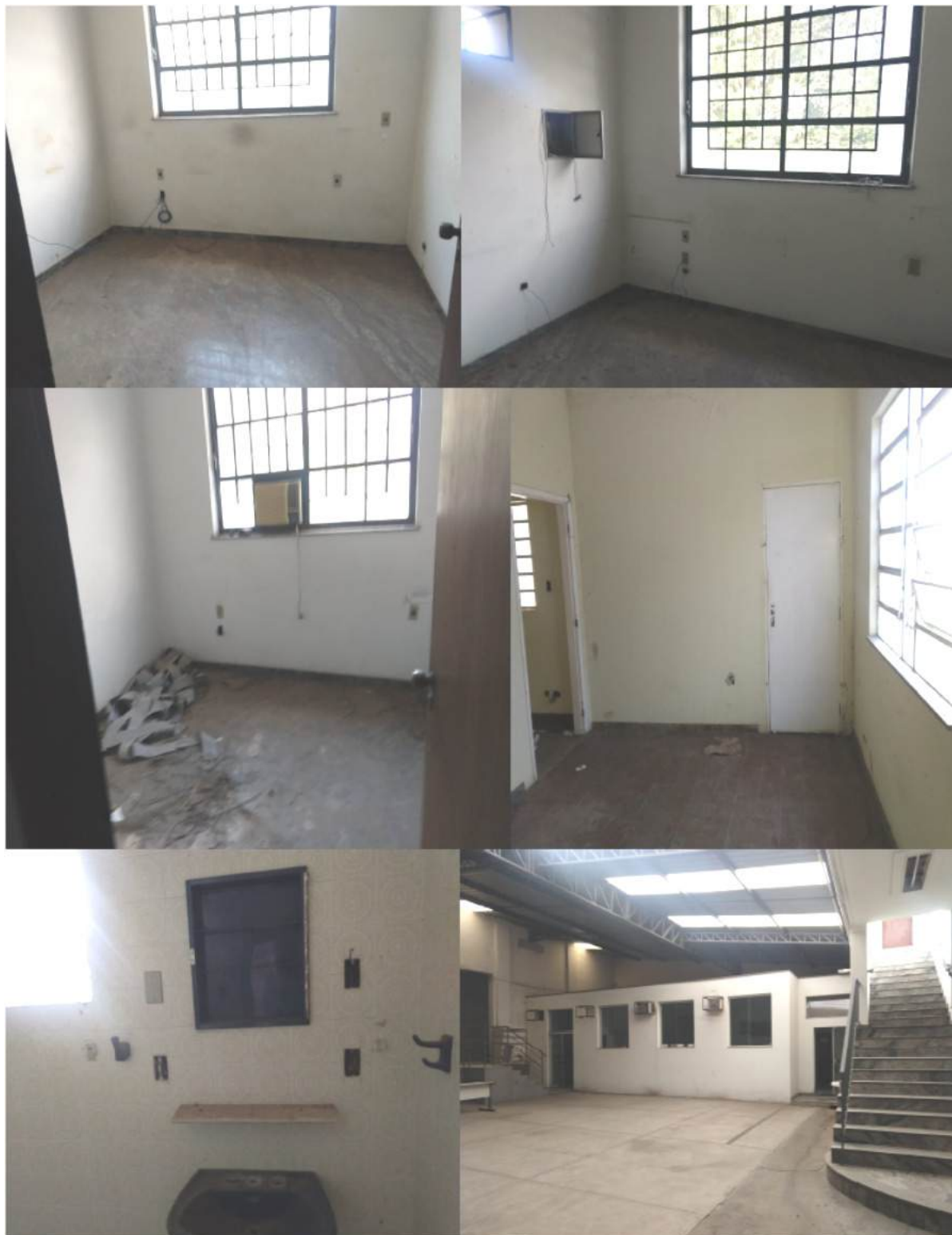
- Visão geral da área interna (repartições).
