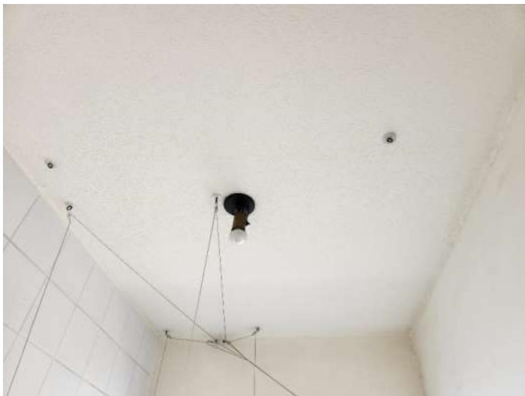
Teto da área de serviço.
