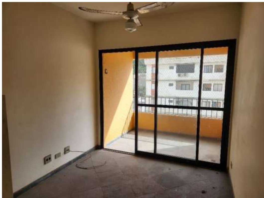
Sala e caixilho do terraço.
