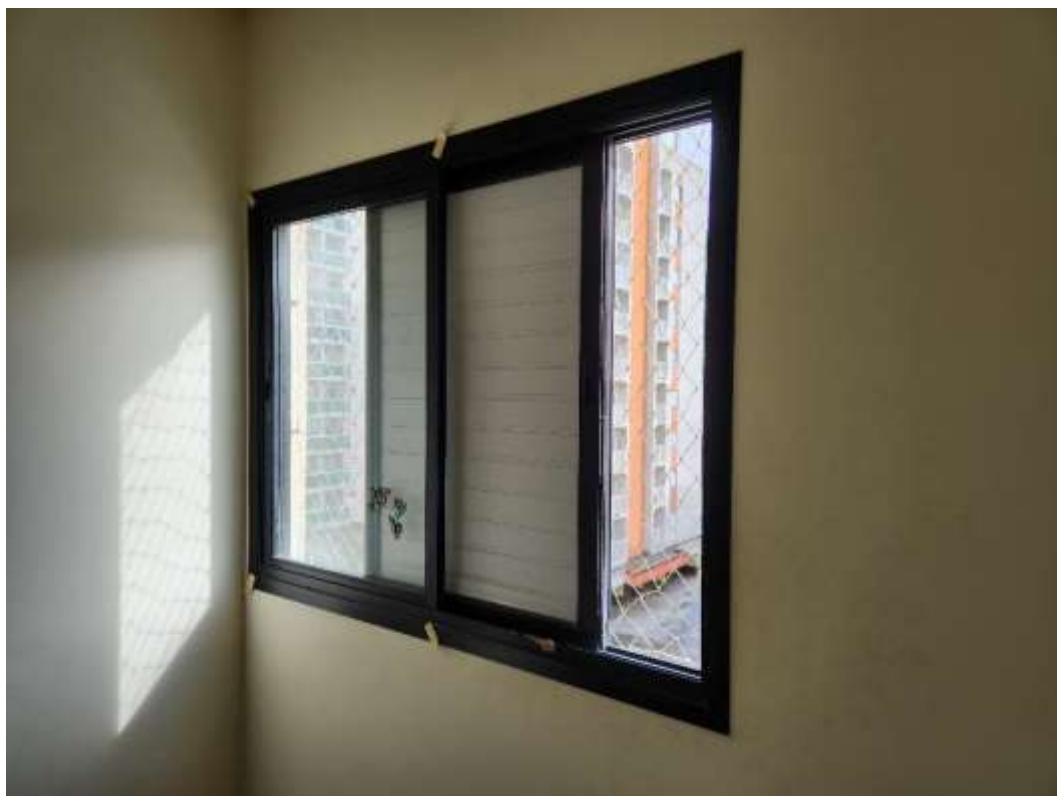
Caixilho em vista aproximada.
