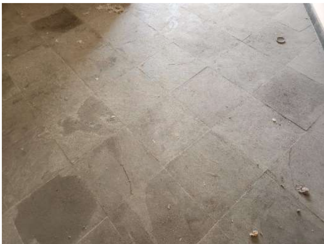
Piso revestido em pedra ardósia.
