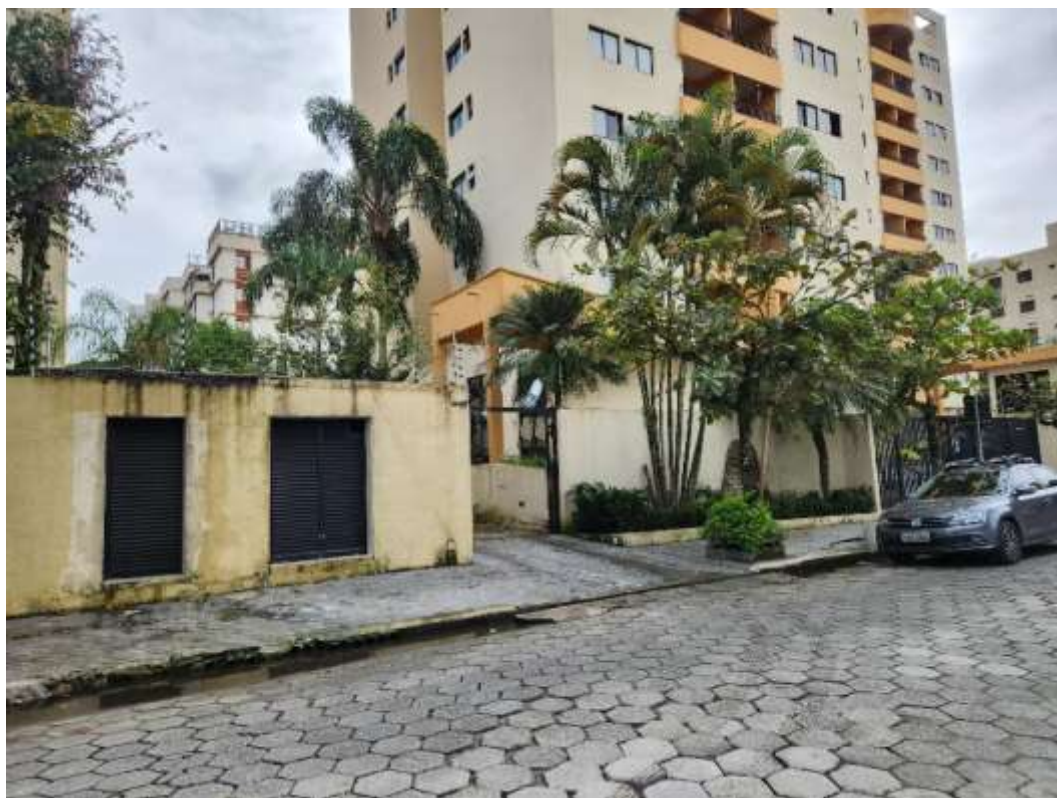
Acesso ao pavimento de garagem no subsolo.
