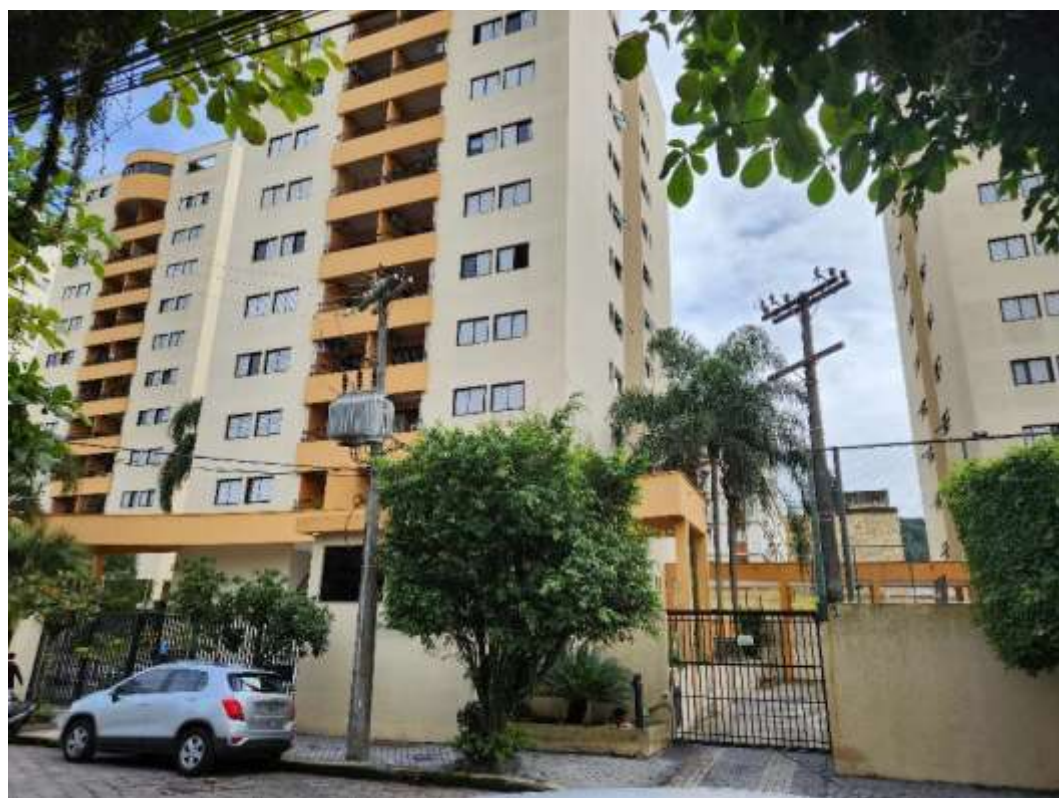
Portão de acesso ao pátio de estacionamento no pavimento térreo do condomínio.
