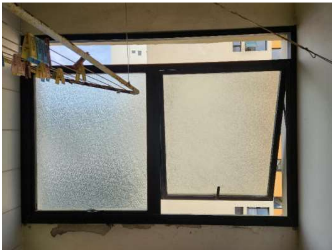
Caixilho da área de serviço.
