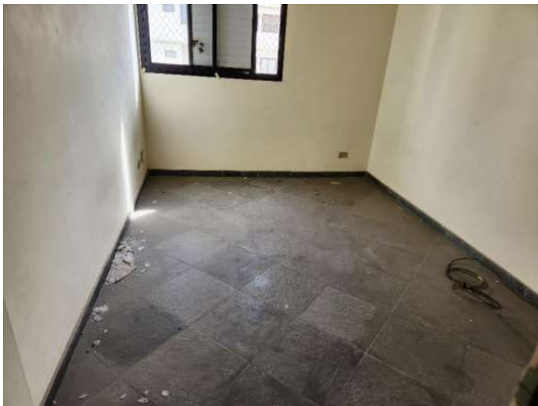
Piso do dormitório em detalhe.
