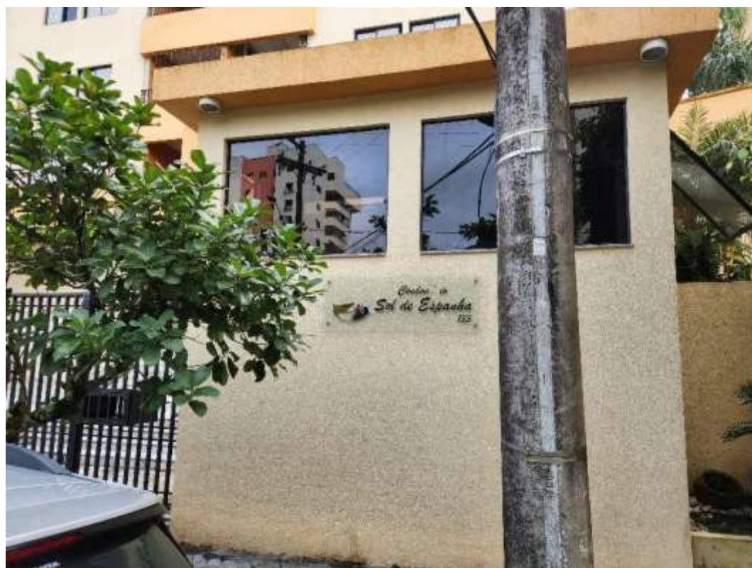
Portaria do condomínio.
