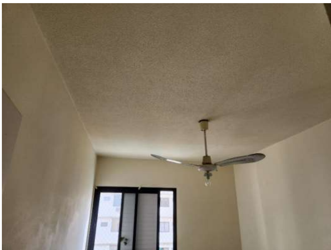
Teto do dormitório e iluminação sobreposta.
