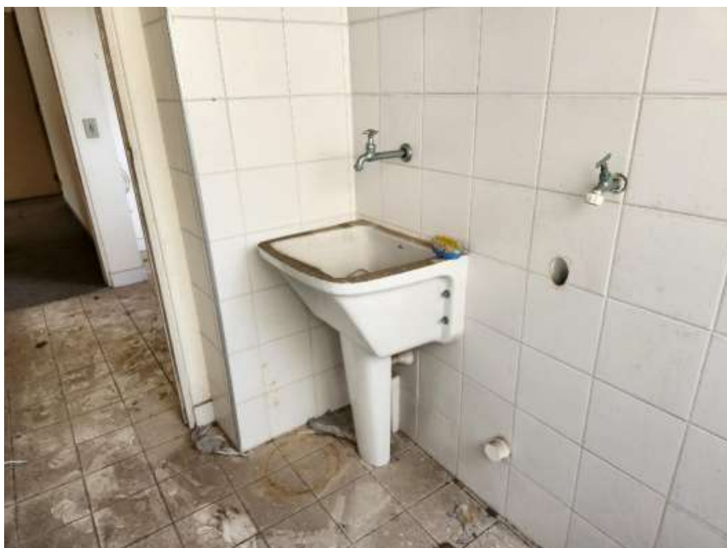
Tanque na área de serviço.
