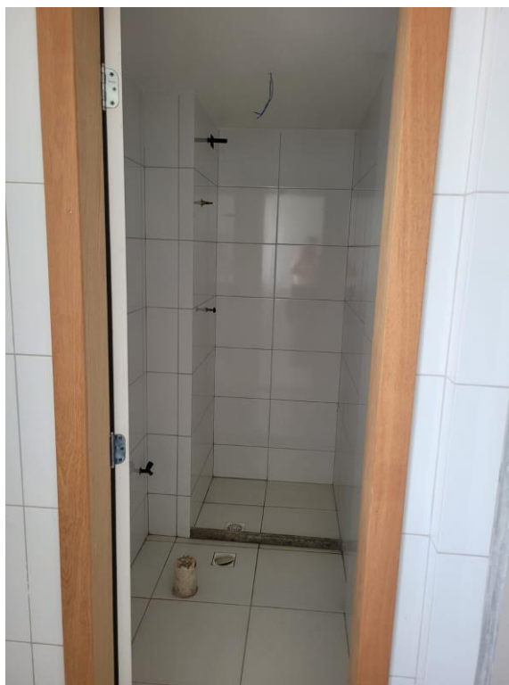
Foto 15 – Banheiro de empregada
