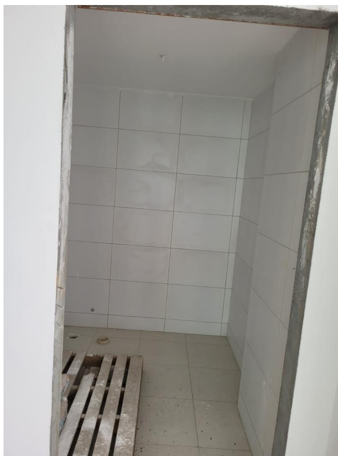
Foto 60 – Banheiro área de lazer
