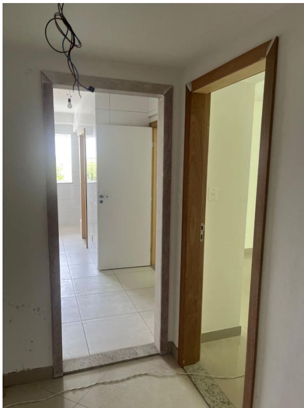
Foto 3 – Entrada do apartamento
