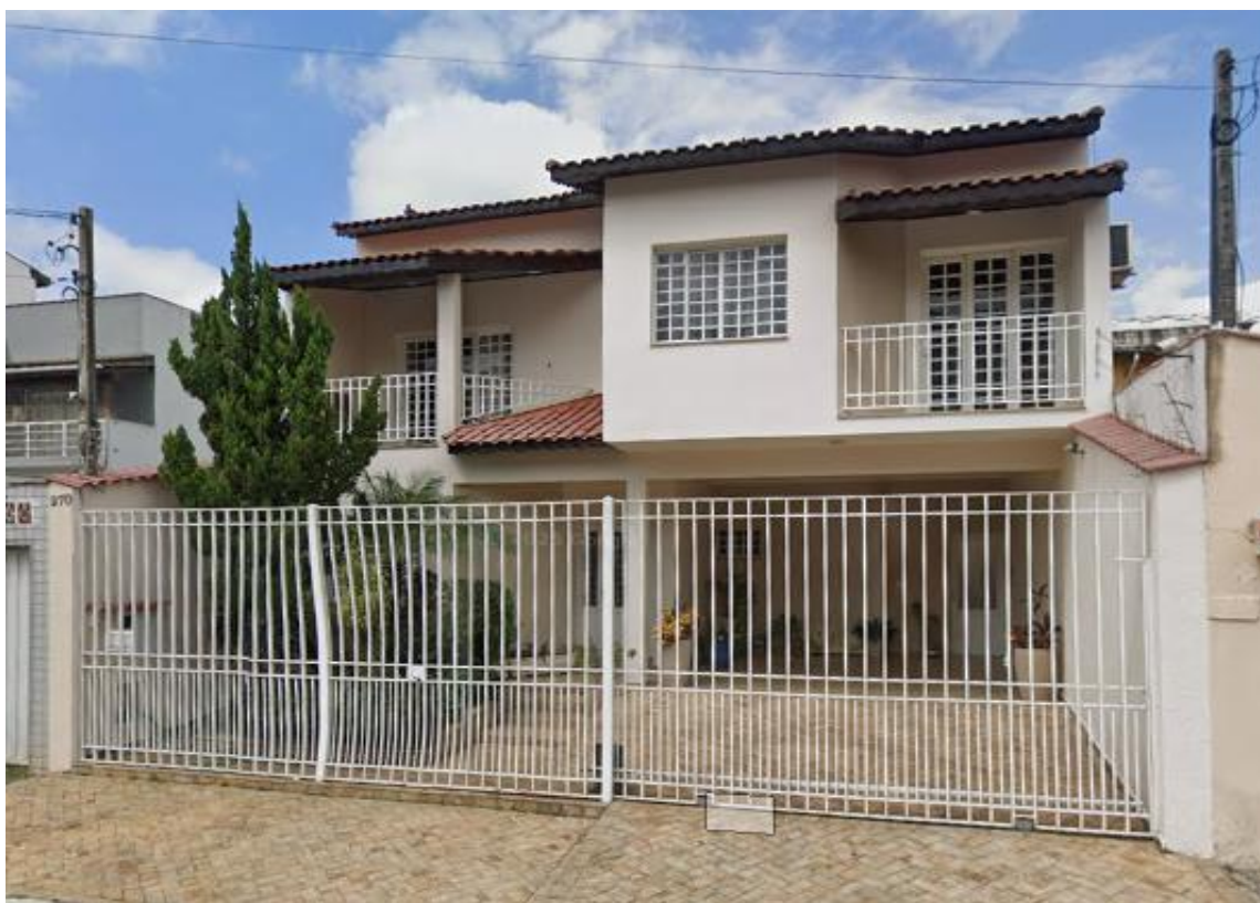
Fachada do Imóvel Avaliando - Data: 20/03/2025
