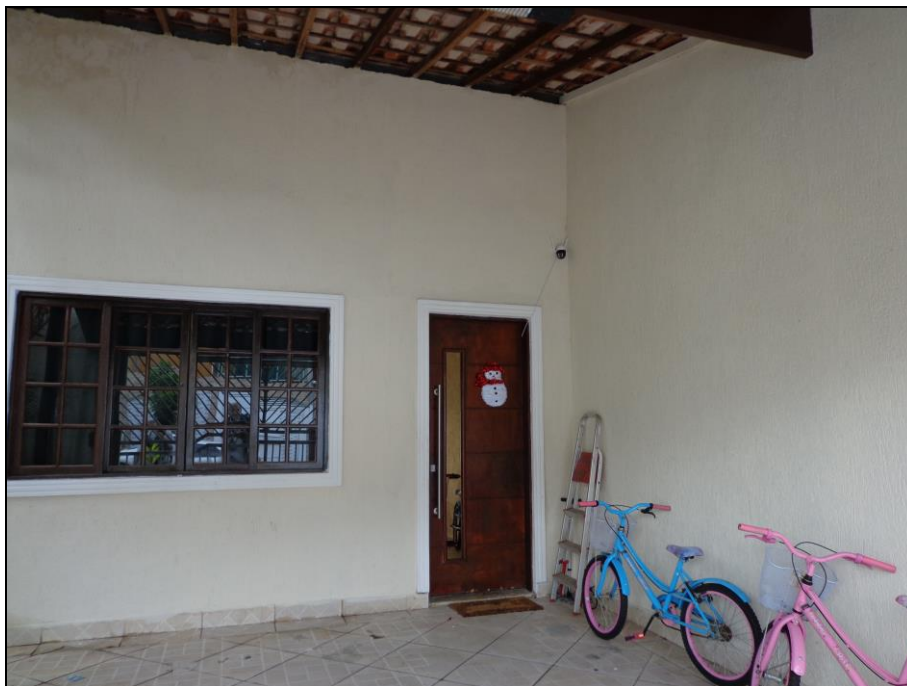
Vista da entrada do imóvel.
