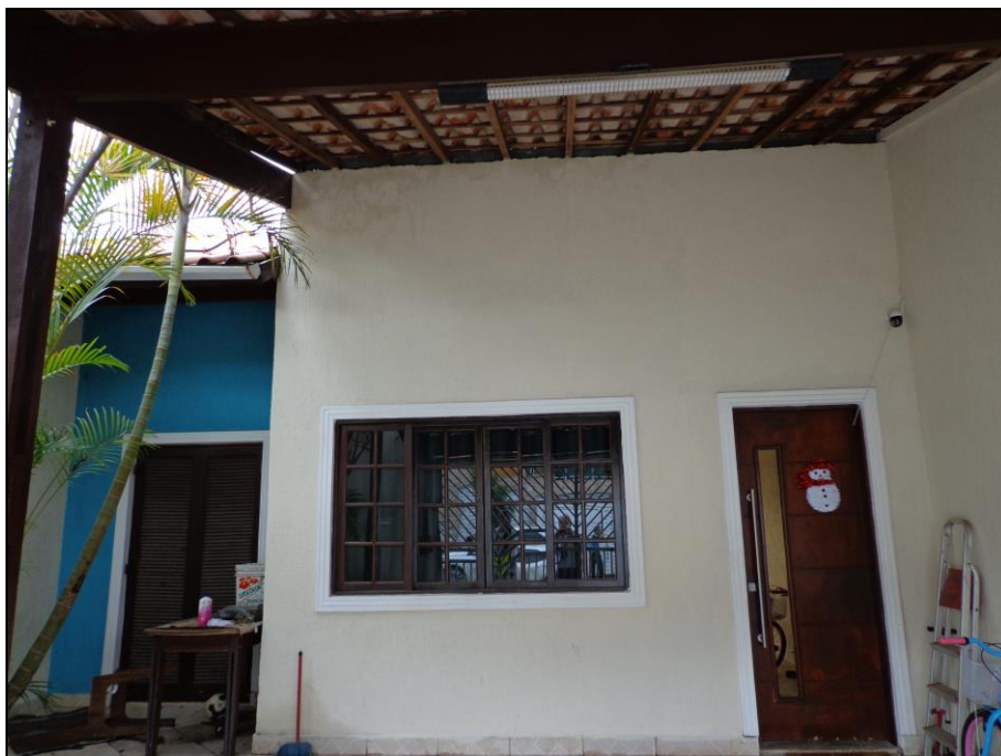
Vista da garagem.
