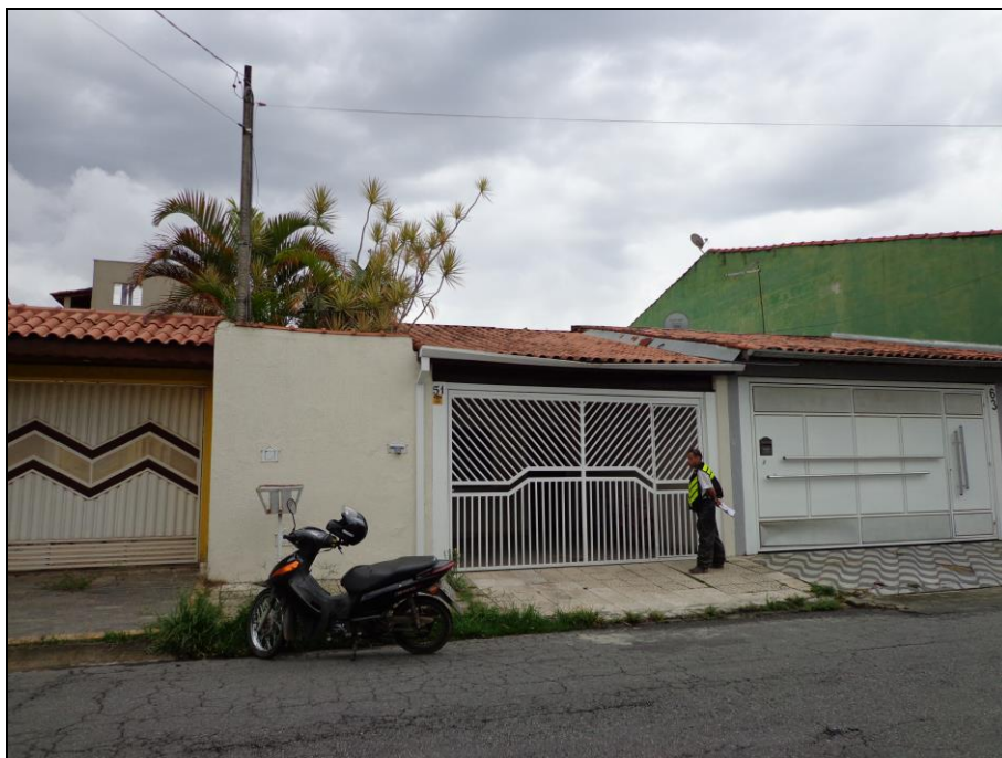
Vista da frente do imóvel.
