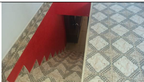
Vista da escada de ligação dos 2 pavimentos.
