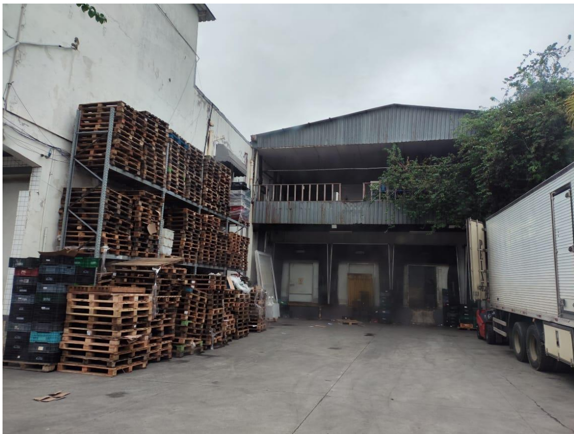
FACHADA INTERNA DO IMOVEL
