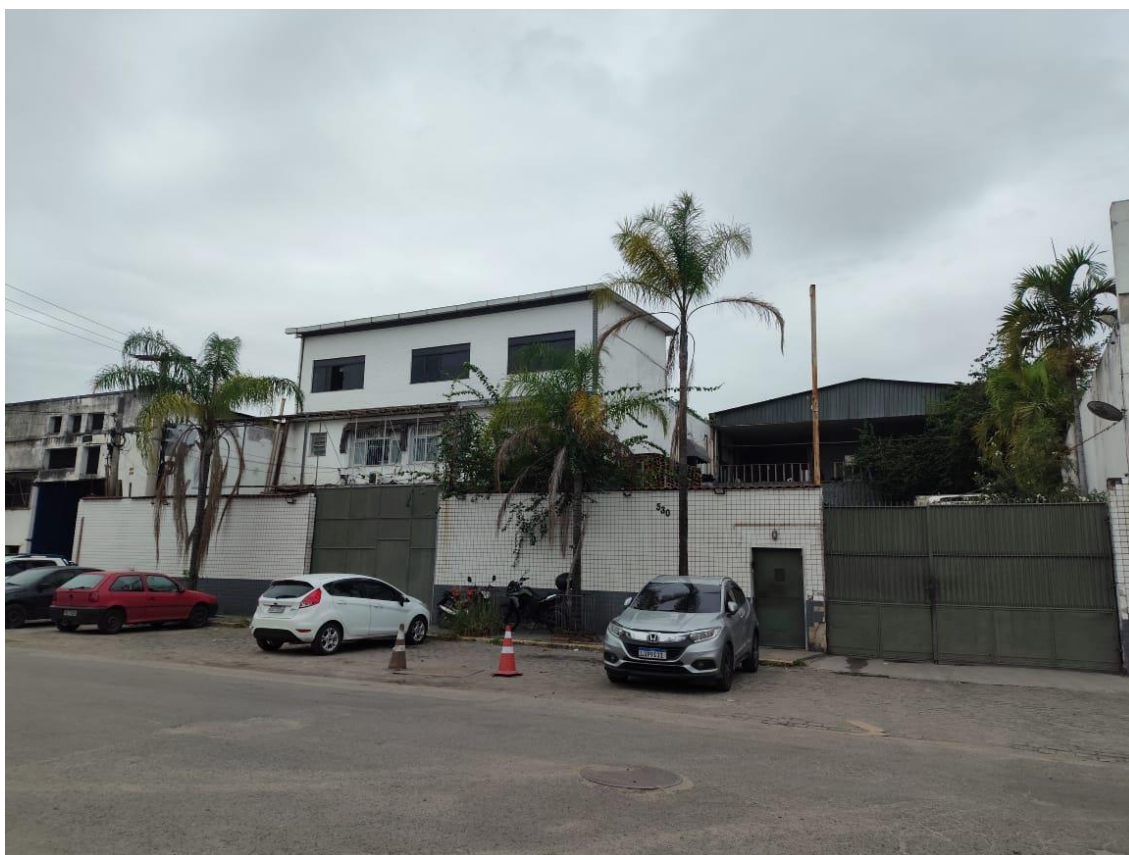
VISTA FACHADA DO IMÓVEL E FACHADA DO VIZINHO
