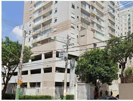
Representação Fachada Principal Descrição Data Foto 19/04/2023
