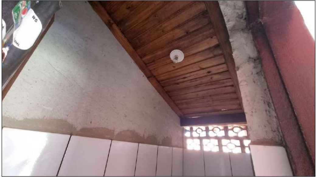
| FOTO 15: Vista geral do galpão.
