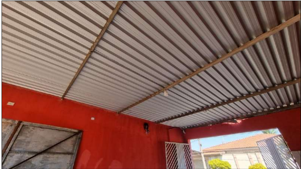
| FOTO 12: Vista geral do galpão.
