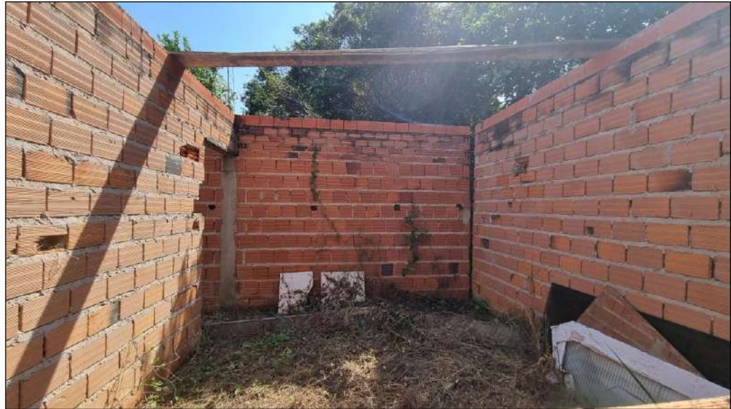
| FOTO 46: Vista geral casa 02 em construção.
