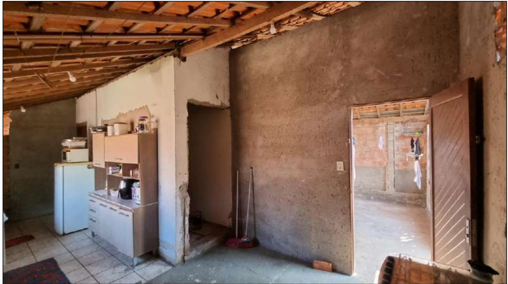
| FOTO 36: Vista geral da cozinha.
