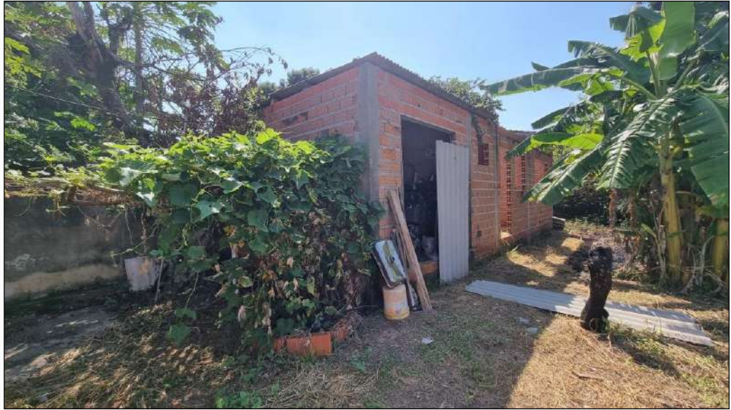
| FOTO 43: Vista geral casa 02 em construção.
