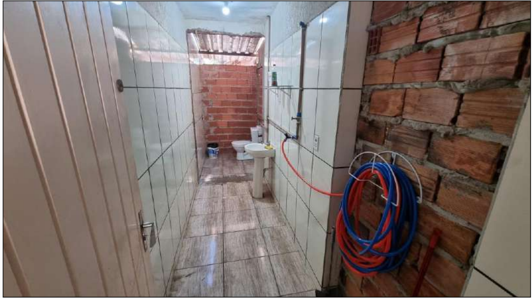
| FOTO 5: Vista geral do banheiro
