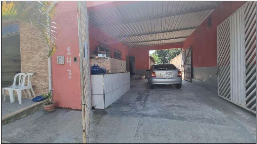
| FOTO 9: Vista geral do galpão.
