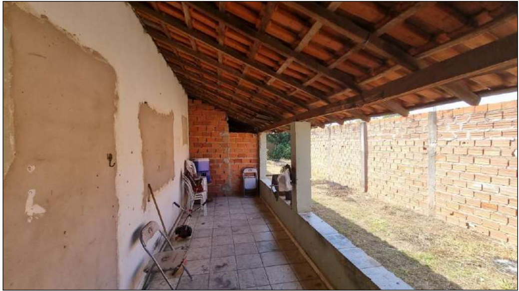
| FOTO 18: Vista geral da casa 01.
