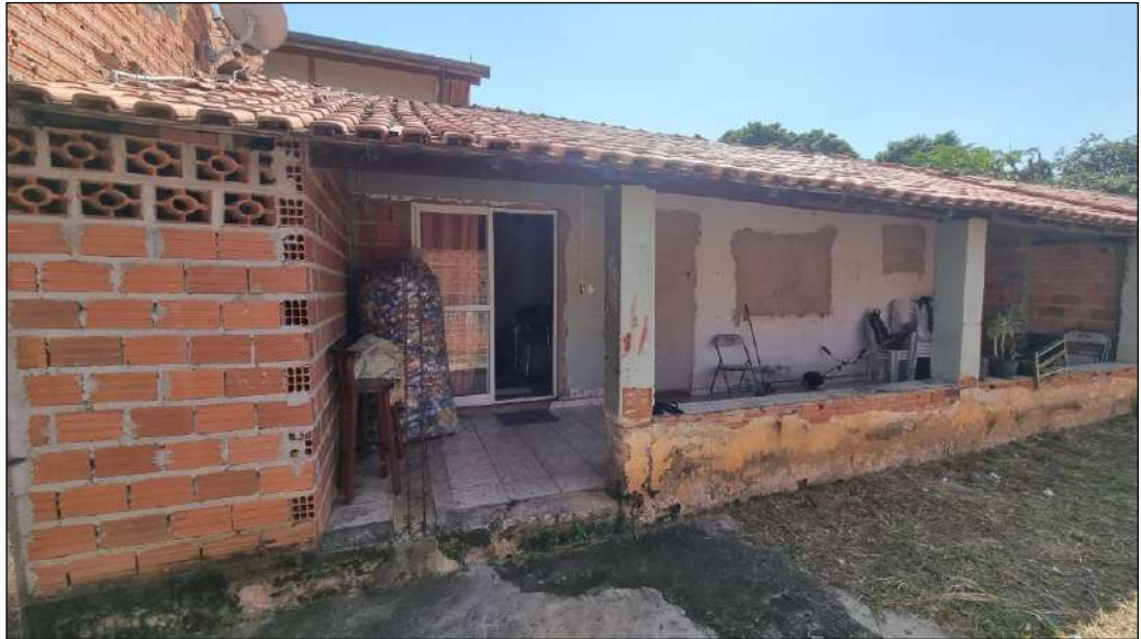
| FOTO 16: Vista geral da casa 01.
