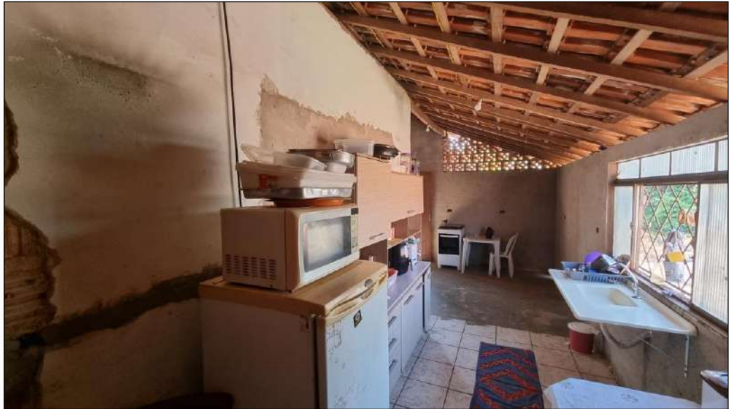
| FOTO 32: Vista geral da cozinha.
