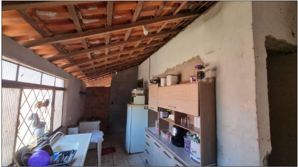
| FOTO 34: Vista geral da cozinha.
