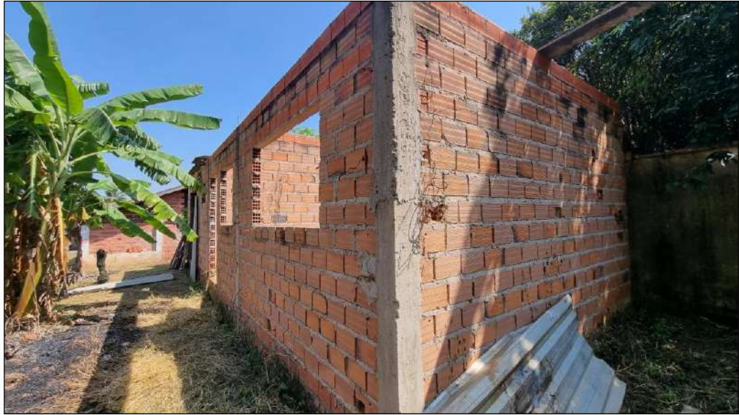
| FOTO 47: Vista geral casa 02 em construção.
