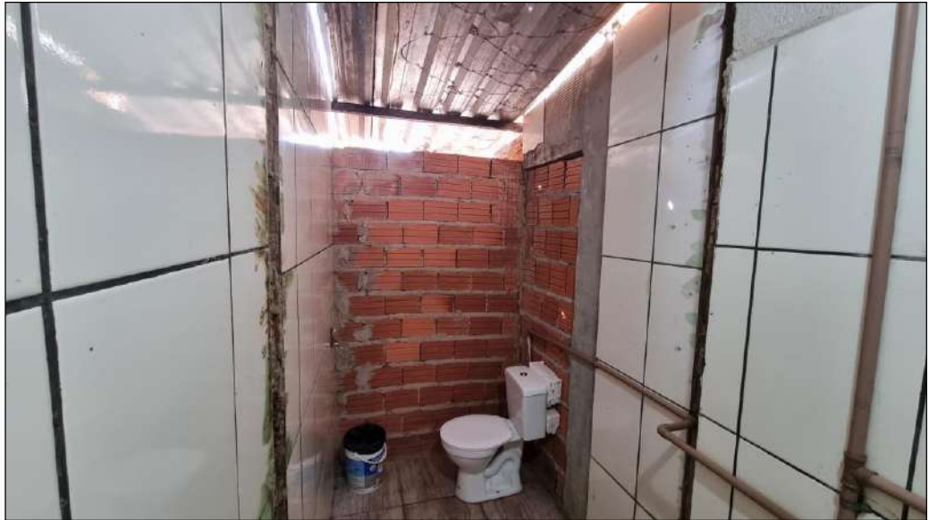
| FOTO 6: Vista geral do banheiro.
