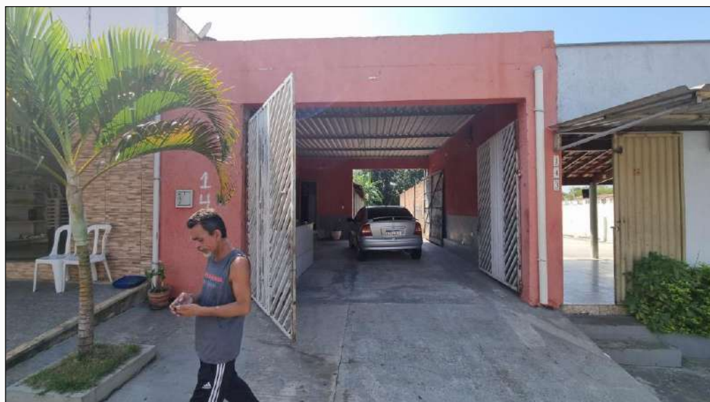
| FOTO 8: Vista geral do galpão.
