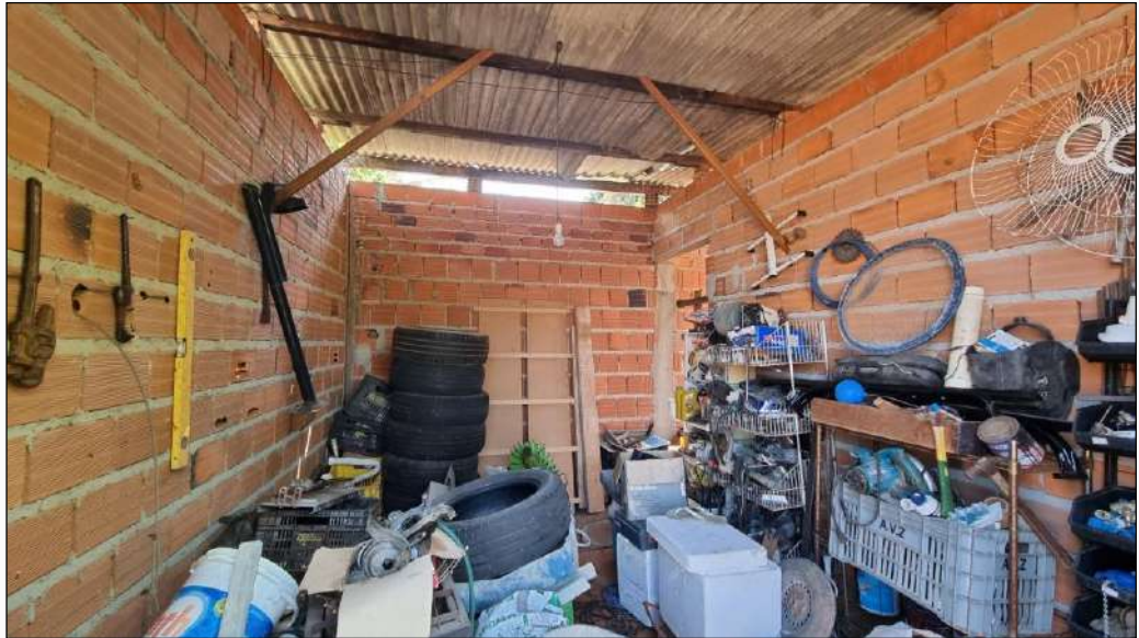
| FOTO 44: Vista geral casa 02 em construção.
