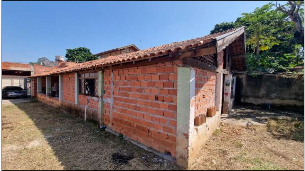
| FOTO 17: Vista geral da casa 01.
