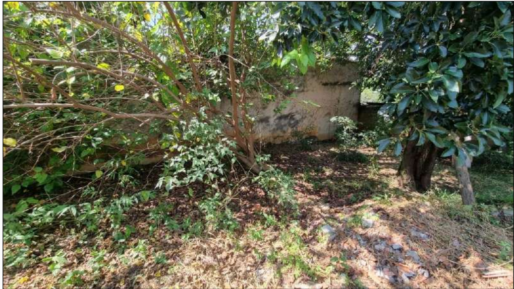
| FOTO 48: Vista geral casa 02 em construção.
