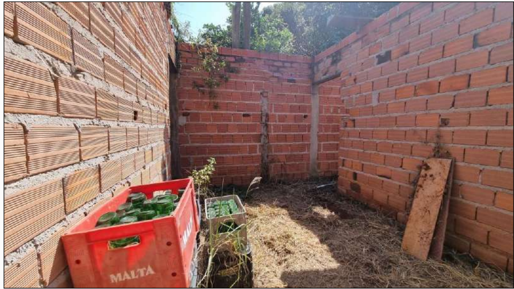
| FOTO 45: Vista geral casa 02 em construção.
