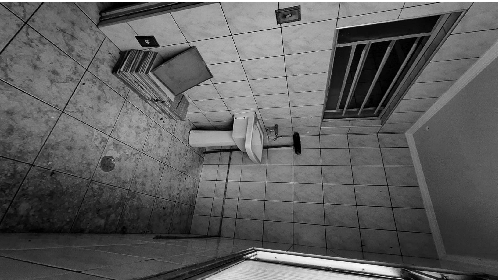
Foto no. 7 - Vista da sala, onde se constata que o imóvel está em mau estado de conservação e com azulejos soltando.
