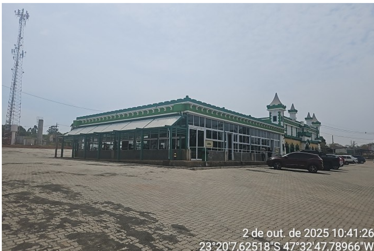
Foto 2 : Vista frontal do imóvel avaliando.
