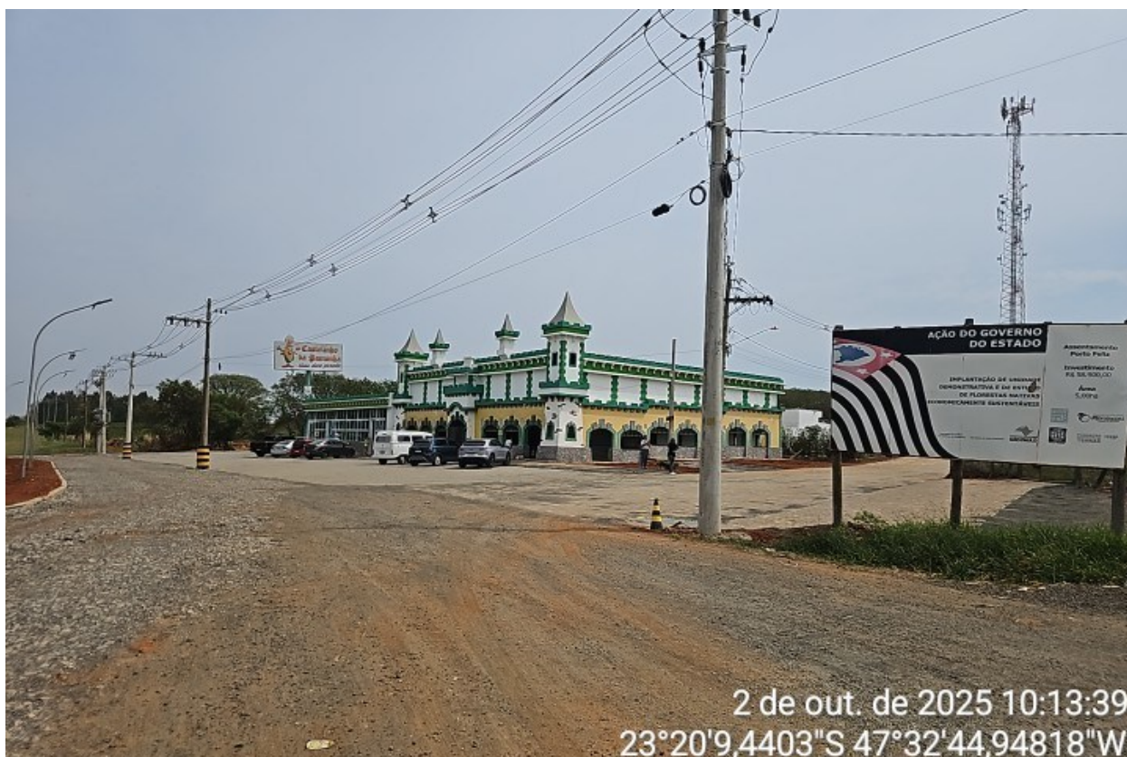
Foto 1 : Vista geral do imóvel avaliando.
