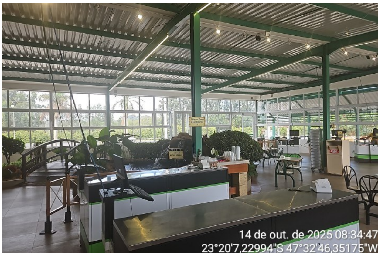
Foto 8 : Vista interna do imóvel avaliando.
