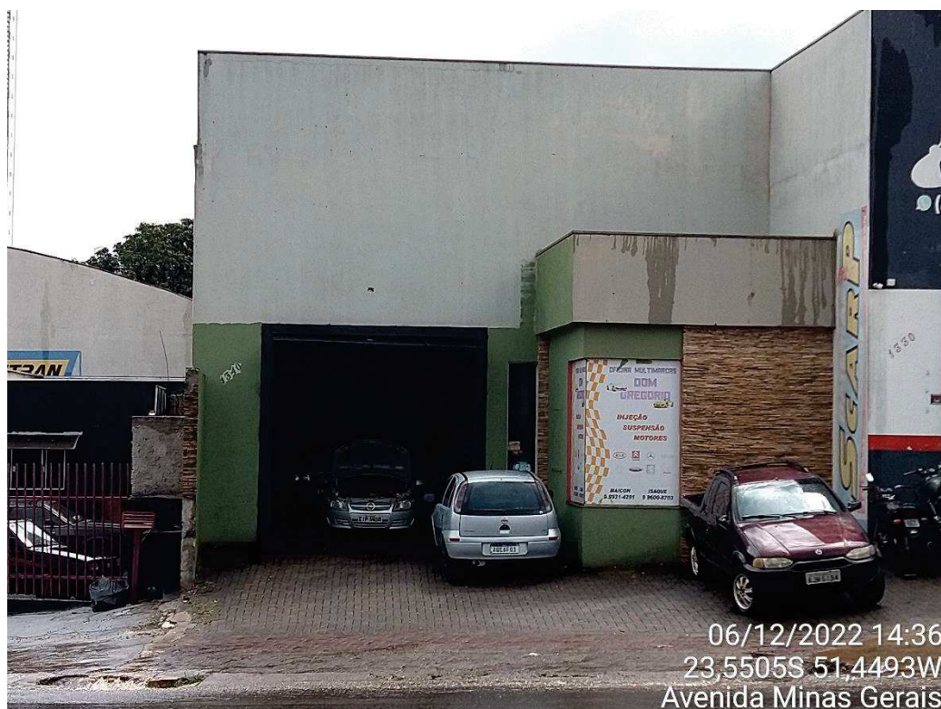
Vista frontal do imóvel.
