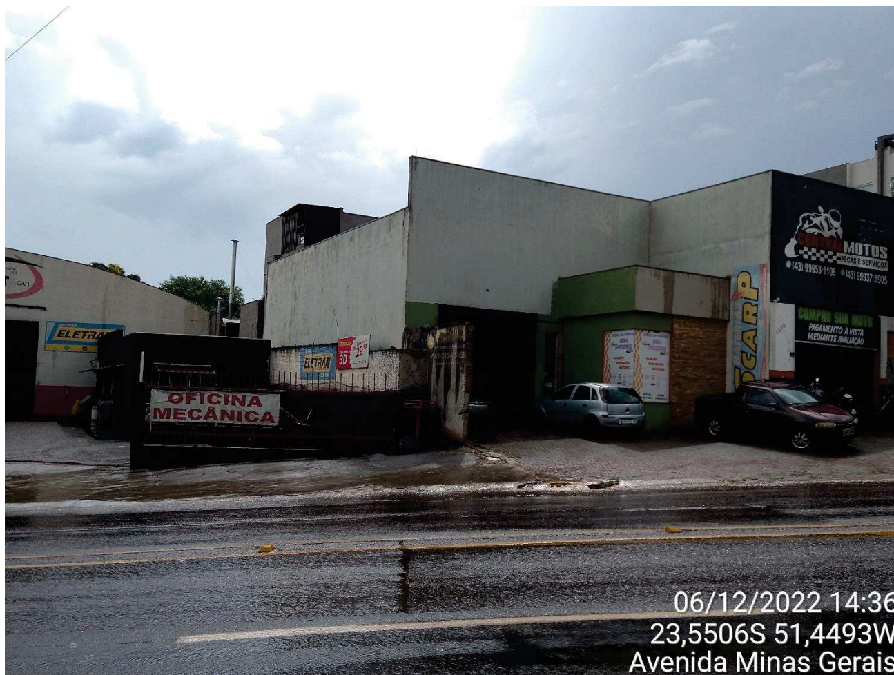
Vista lateral do imóvel.
