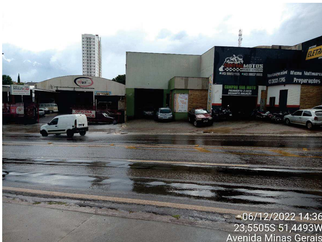
Vista frontal do imóvel.
