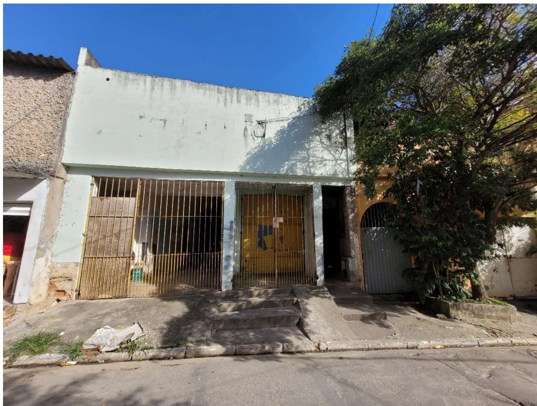
FOTO 01 – FACHADA FRONTAL DO IMÓVEL AVALIANDO
