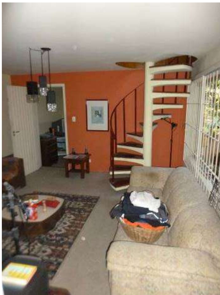
Detalhes de acabamento e conservação do interior da sala.
