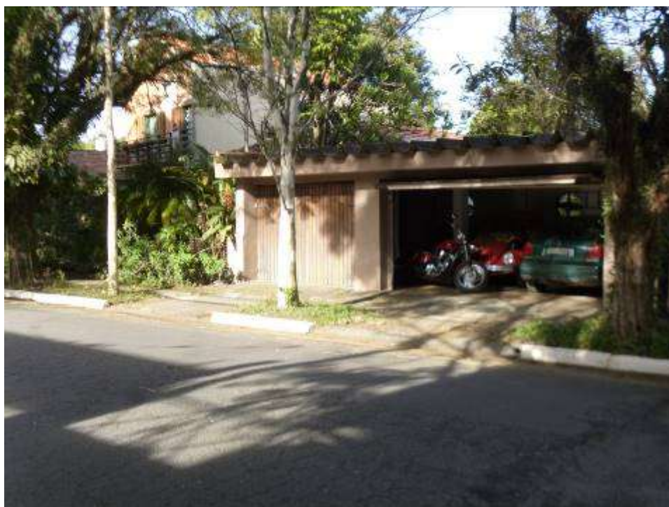
Aspectos parciais da fachada da garagem anexa.
