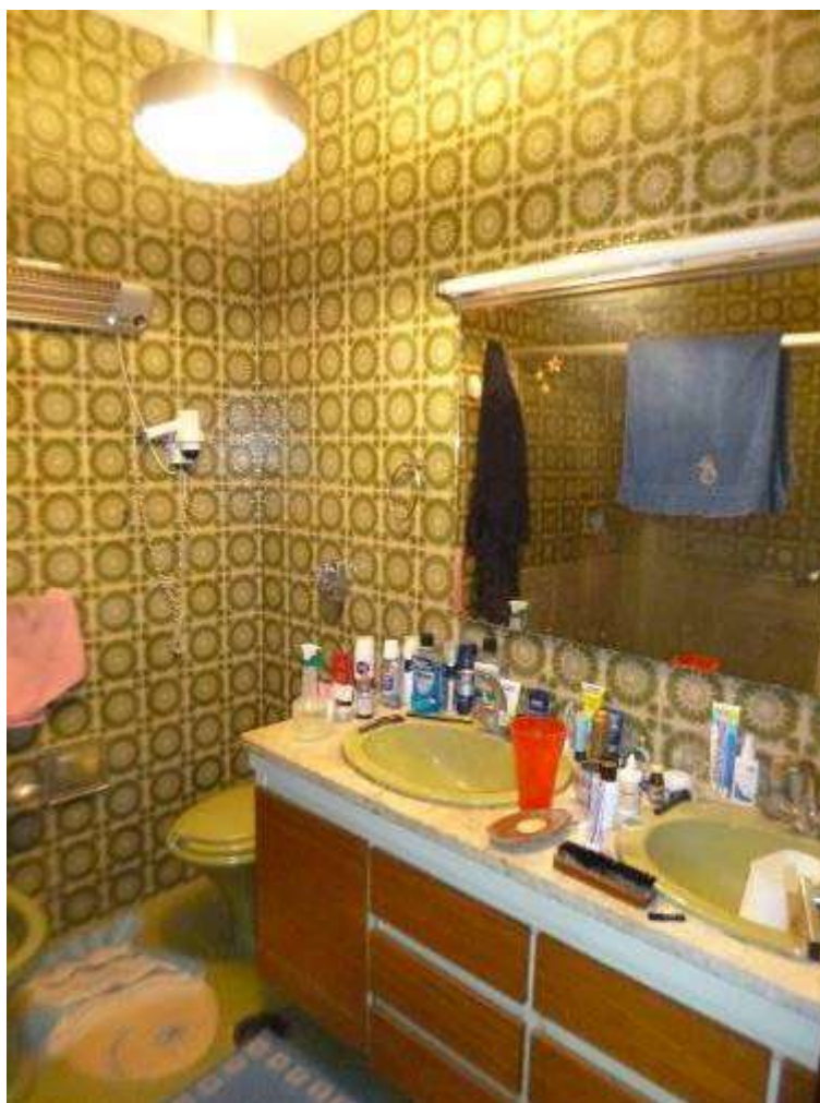
Detalhe de acabamento e estado de conservação do banheiro social.
