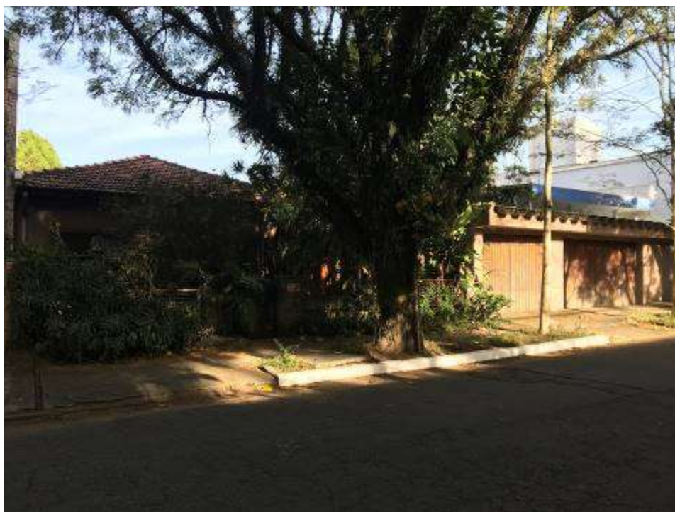
Fachada do imóvel avaliando vista da Rua Tomé Portes.
