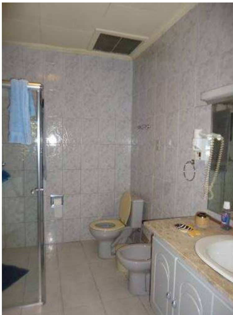
Detalhe de acabamento e estado de conservação do banheiro da suíte.
