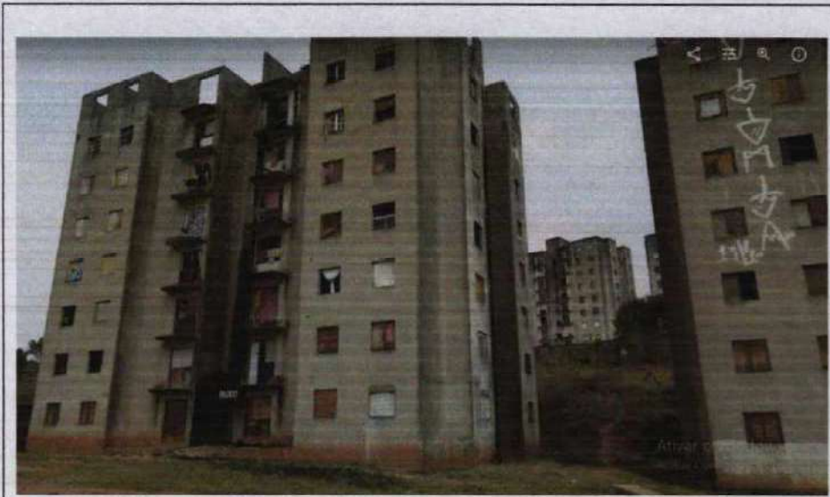
Foto 7 – Dois edifícios não concluídos existentes na Gleba 14D.
