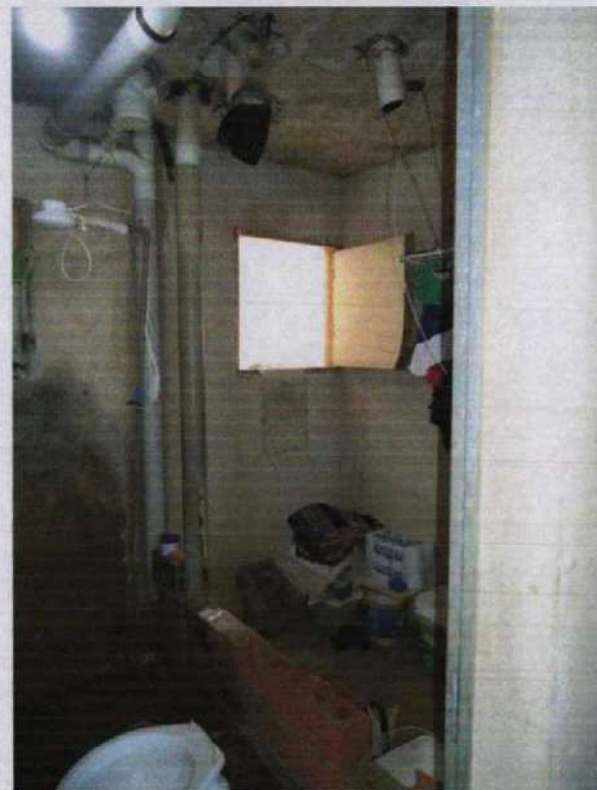
Banheiro do apartamento 13 Bloco C
