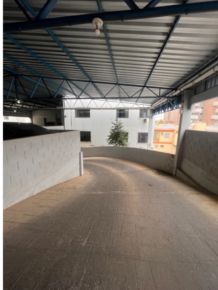
Foto 3: imagem da rampa de acesso a garagem.
