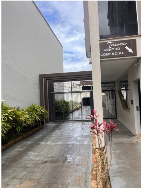
Foto 2: imagem do acesso a garagem.
