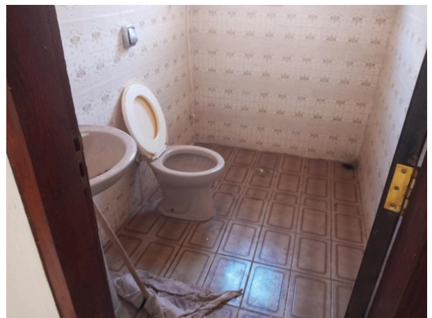
banheiro varanda fundos
