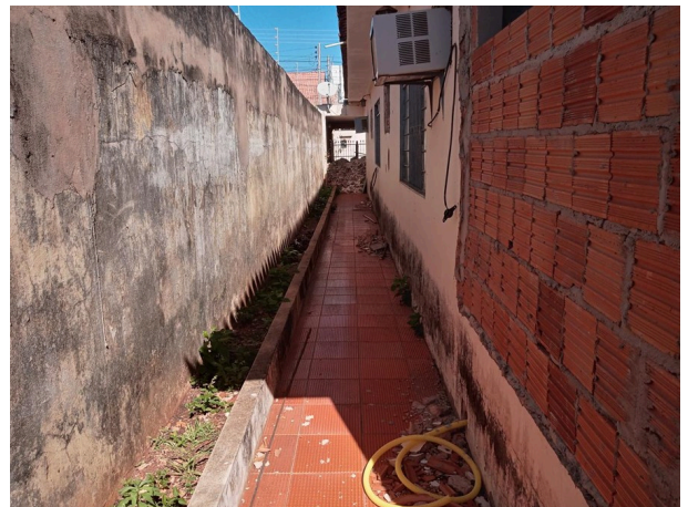
Corredor lateral direita
