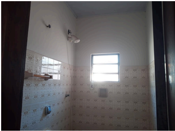
banheiro varanda fundos
