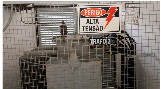
Figura 1 - Transformadores 1000kVA ITAM, ano 2005
