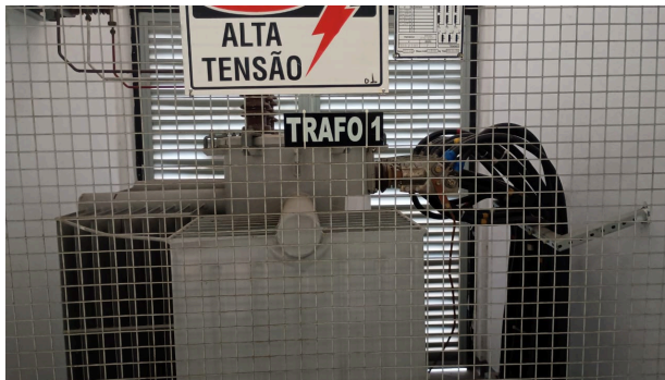
Figura 1 - Transformadores 1000kVA ITAM, ano 2005
