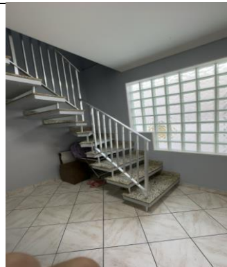
ESCADA DE ACESSO
