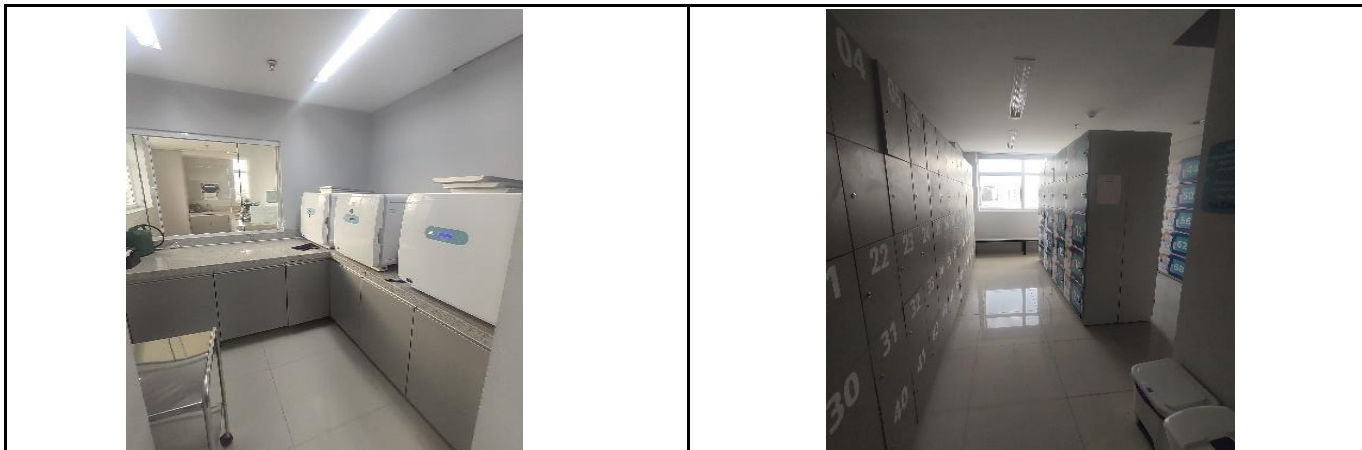
Material contaminado - Sala 03
