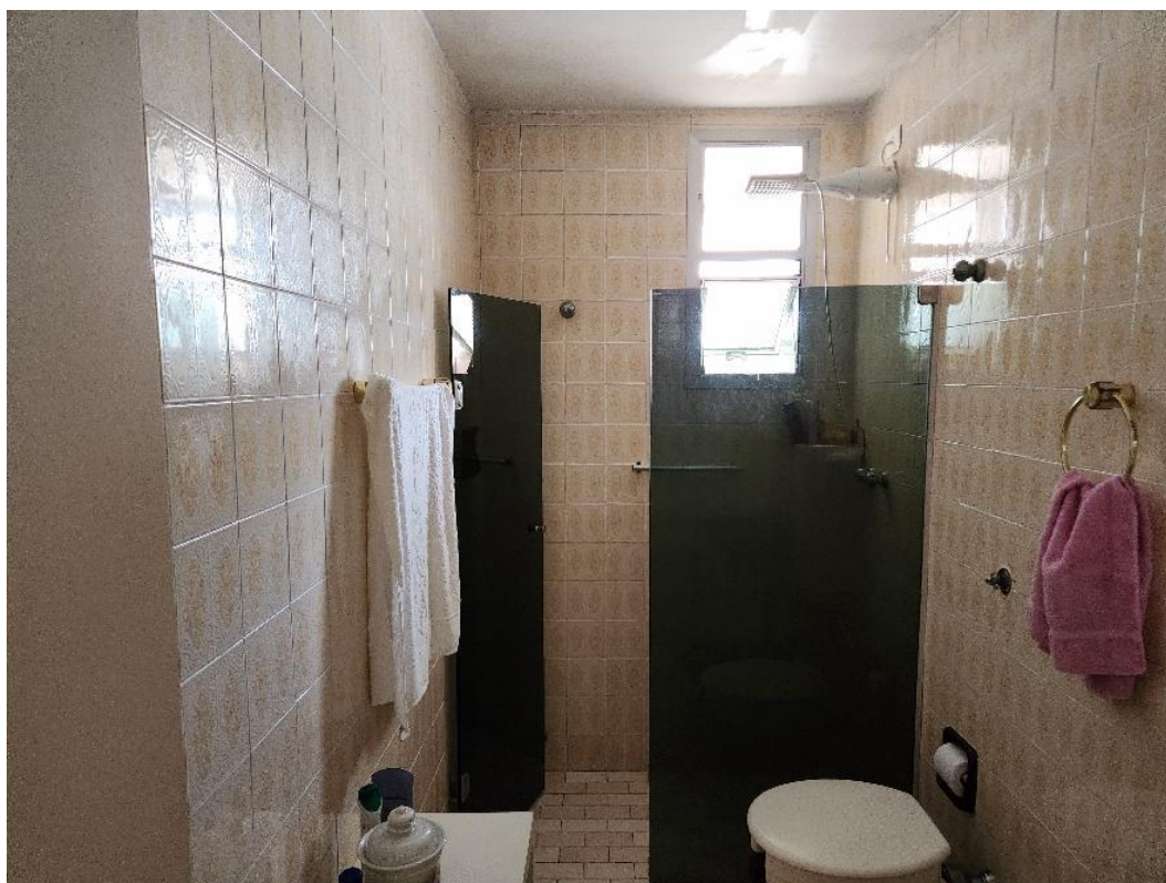
Mais uma vista do mesmo banheiro.
