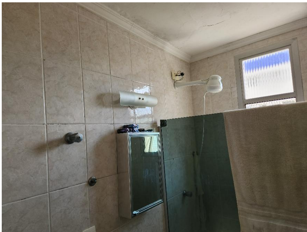
Revestimento cerâmico sobre as paredes até o teto.
