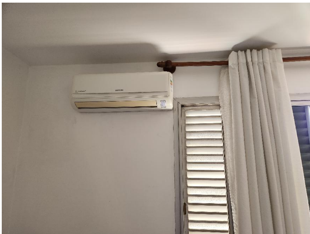
Detalhe do caixilho em alumínio e ar-condicionado.
