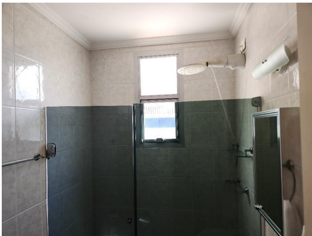
Área do box do banheiro.
