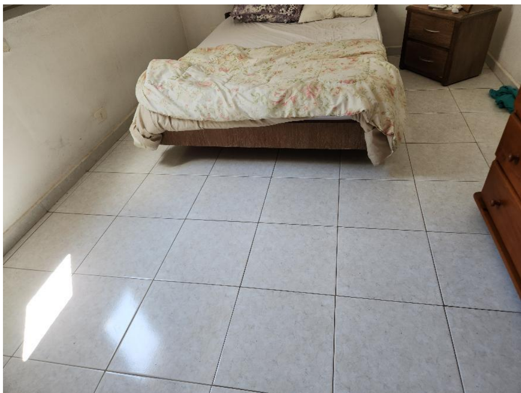
Revestimento cerâmico sobre o piso da suíte.
