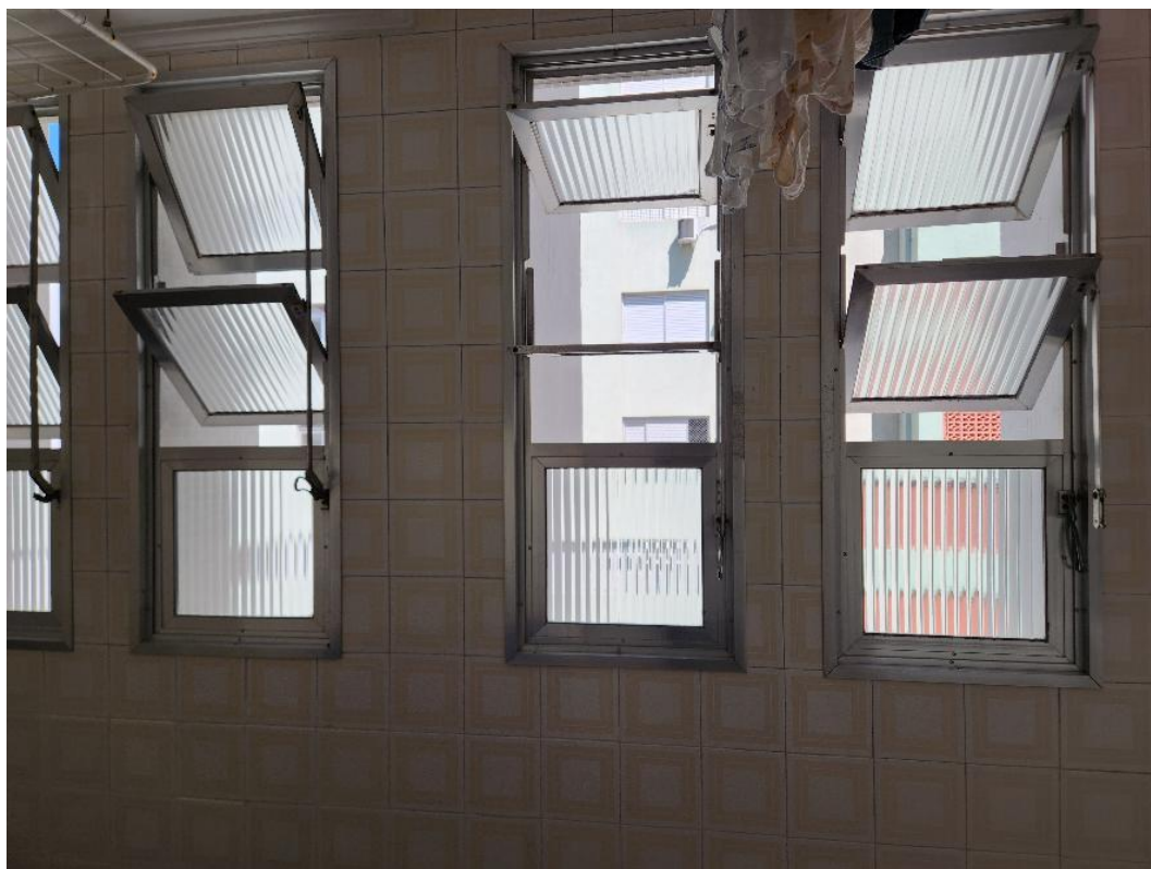
Caixilho da área de serviço em detalhes.
