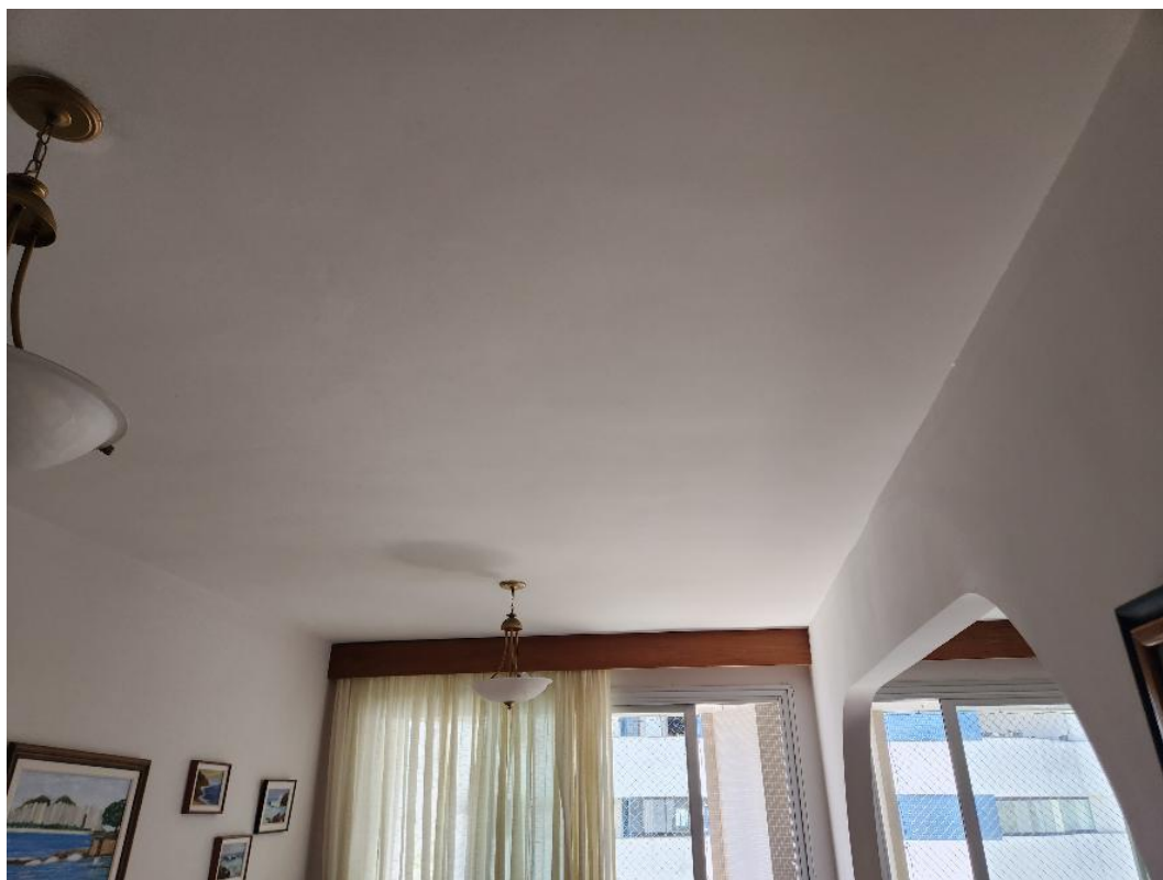
Teto da sala de estar com iluminação sobreposta.
