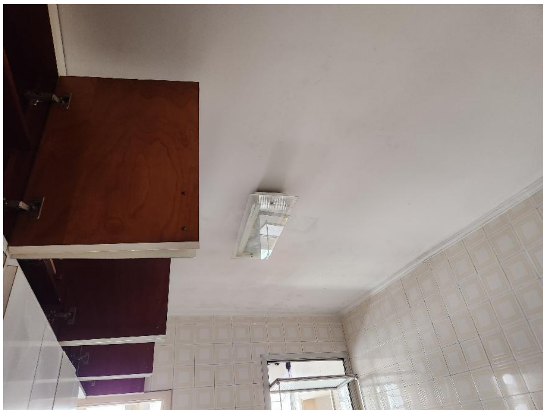
Teto da cozinha com iluminação sobreposta.
