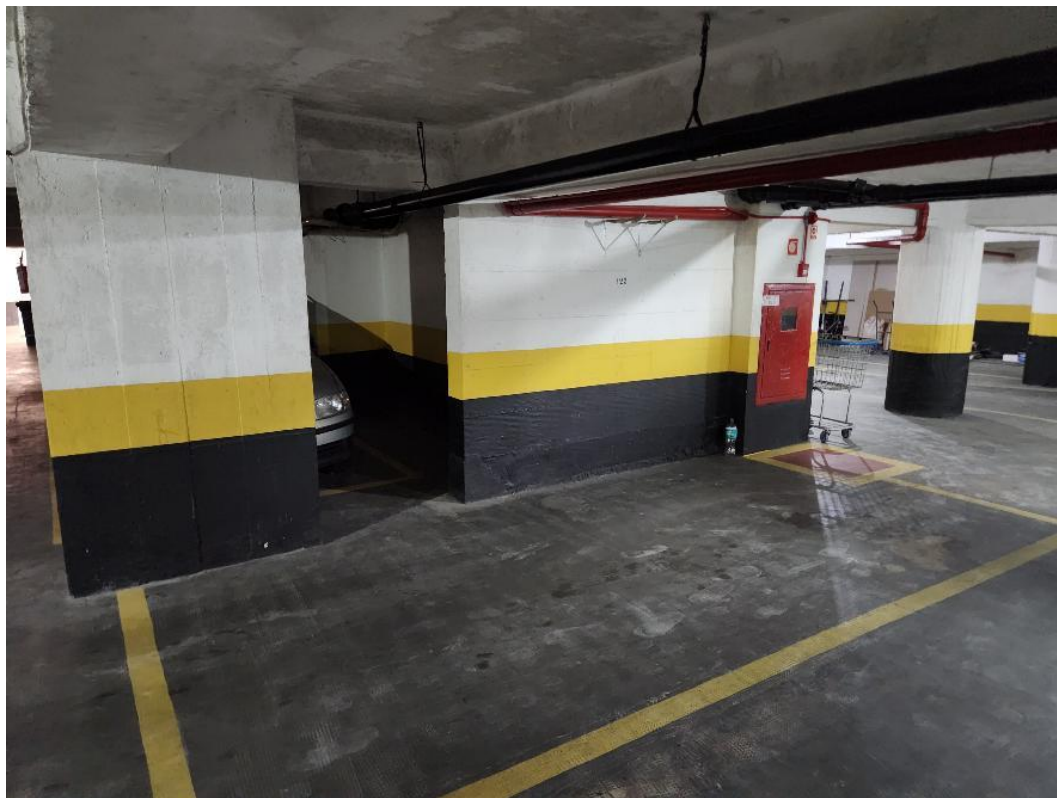
Vaga de estacionamento no pavimento subsolo identificada pelo nº 123.
