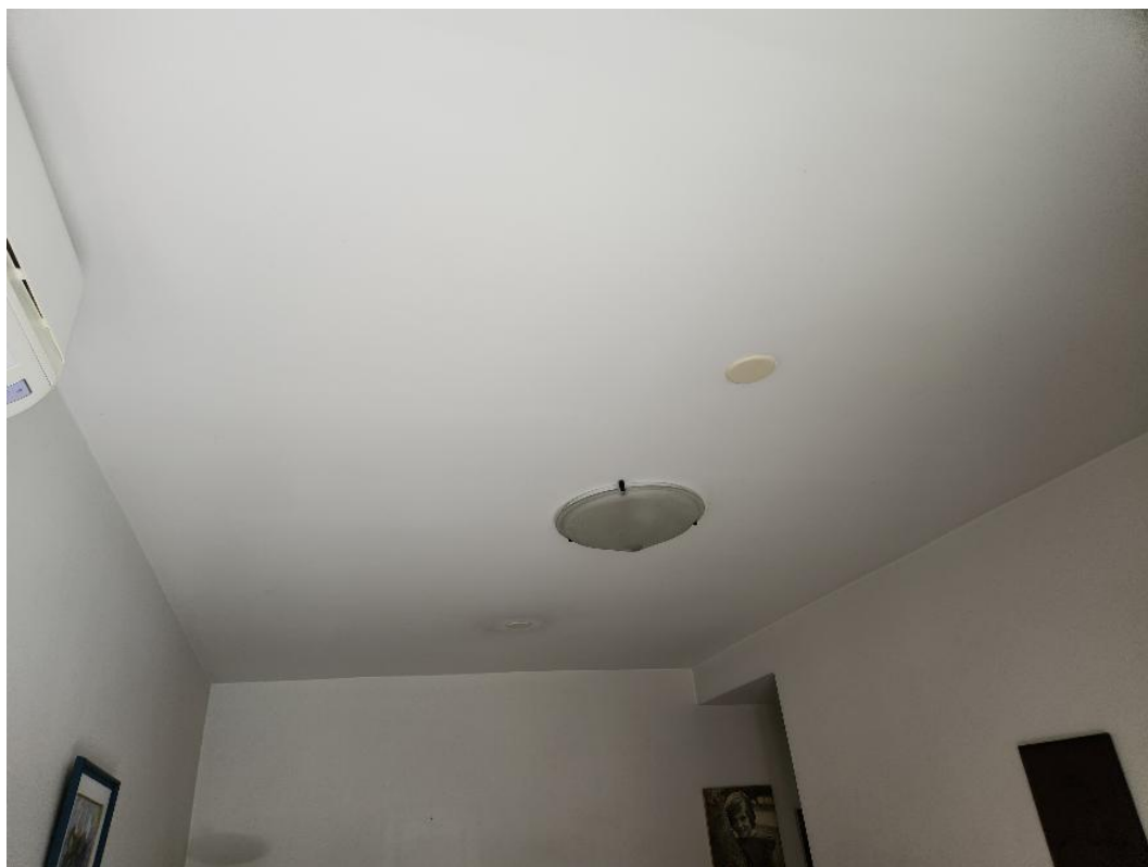
Teto do dormitório com iluminação sobreposta.
