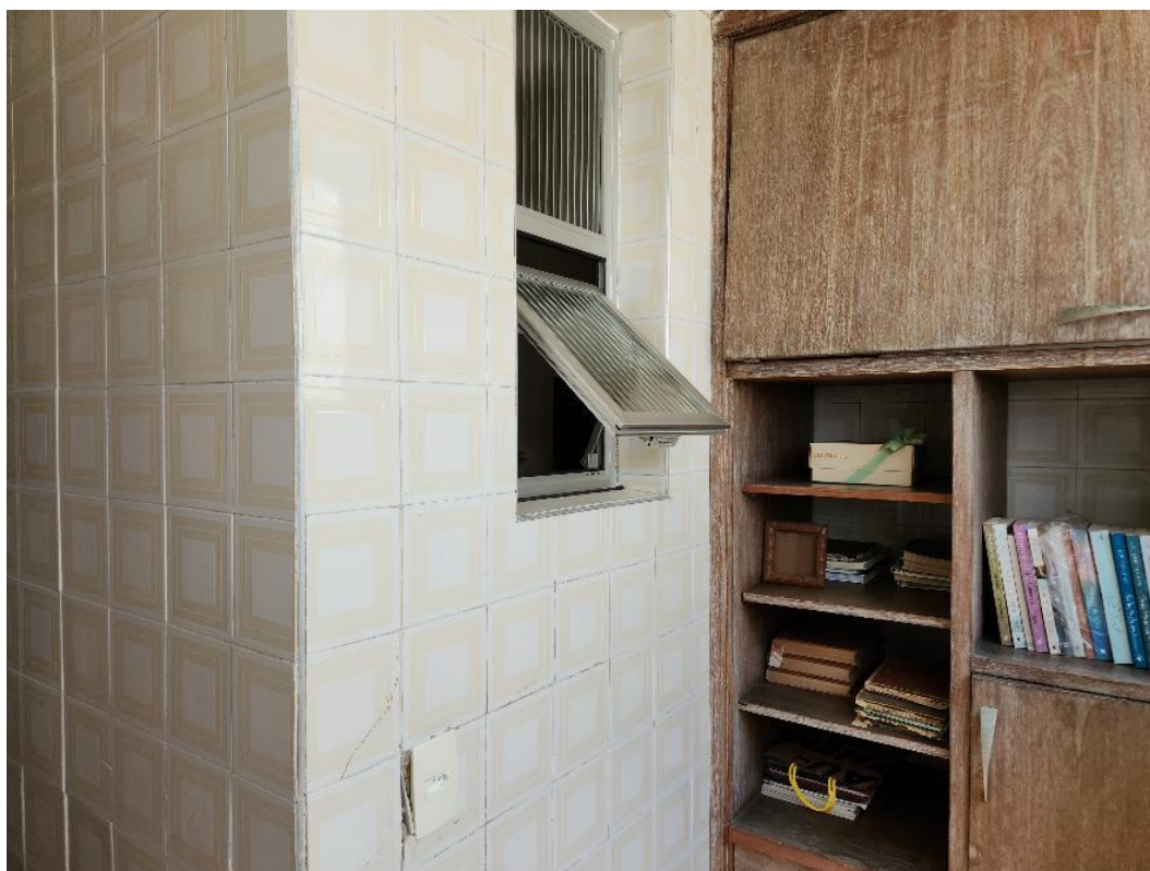
Janela do banheiro caracterizado anteriormente voltada para a área de serviço.
