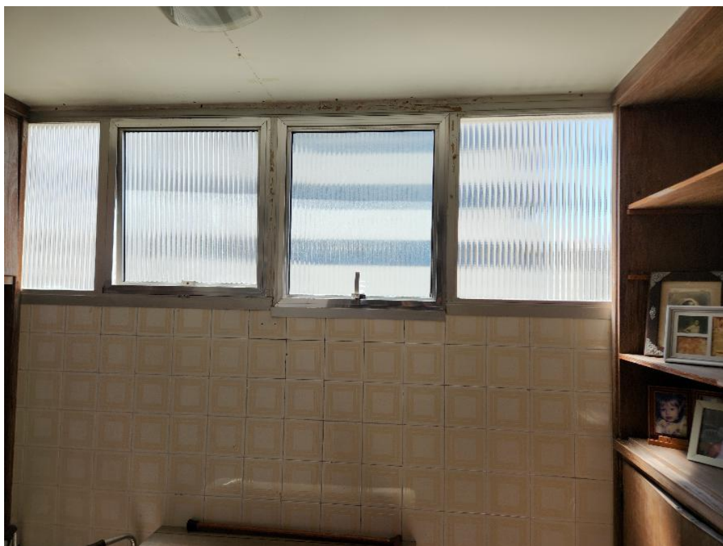
Caixilhos da área de serviço em mais detalhes.
