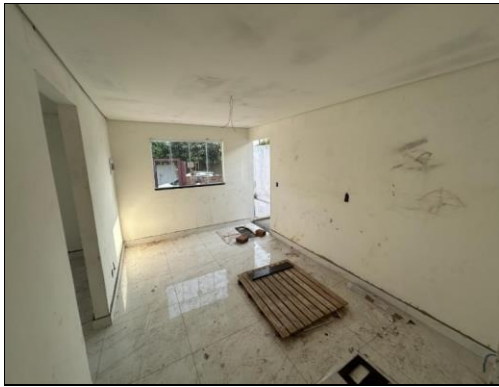
VISTA PARCIAL DA OBRA
