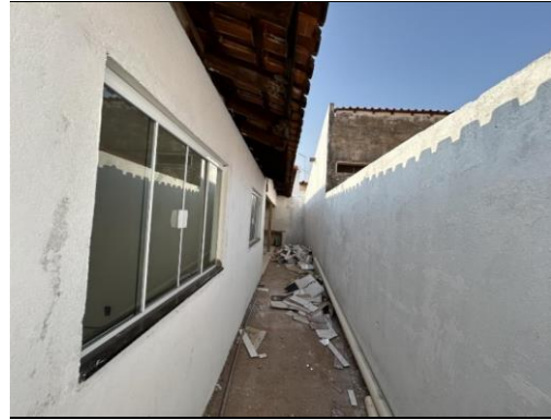
VISTA PARCIAL DA OBRA
