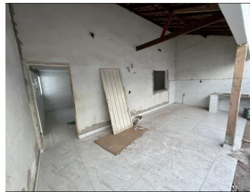
VISTA PARCIAL DA OBRA
