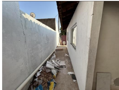
VISTA PARCIAL DA OBRA
