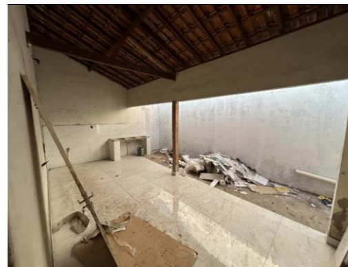
VISTA PARCIAL DA OBRA
