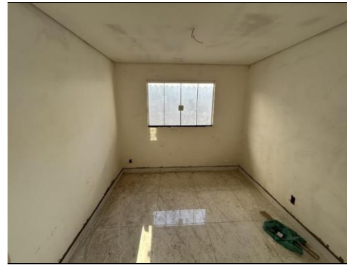
VISTA PARCIAL DA OBRA
