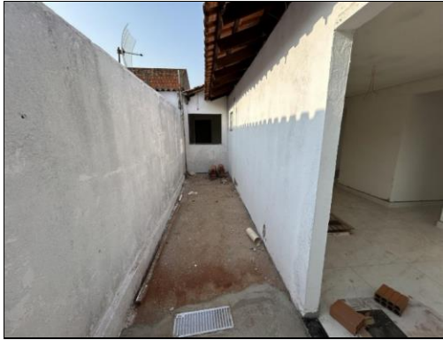
VISTA PARCIAL DA OBRA
