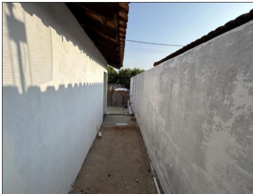
VISTA PARCIAL DA OBRA
