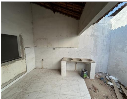
VISTA PARCIAL DA OBRA
