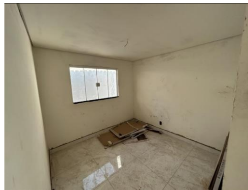
VISTA PARCIAL DA OBRA
