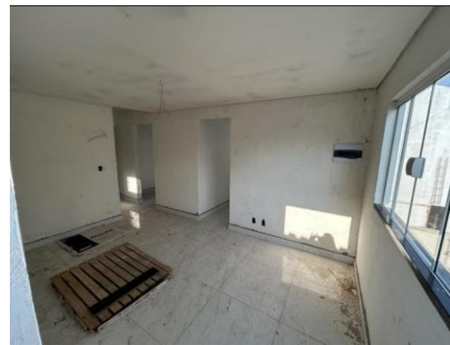
VISTA PARCIAL DA OBRA
