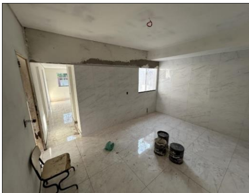
VISTA PARCIAL DA OBRA
