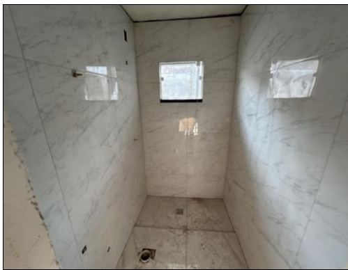
VISTA PARCIAL DA OBRA
