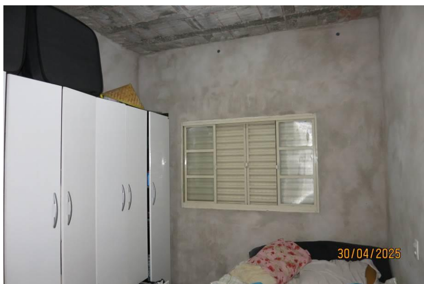
Foto 14: Dormitório do fundo.
