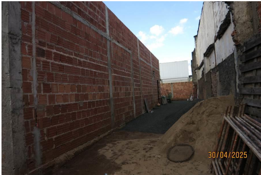
Foto 05: Corredor lateral direito, acesso para o fundo do terreno.
