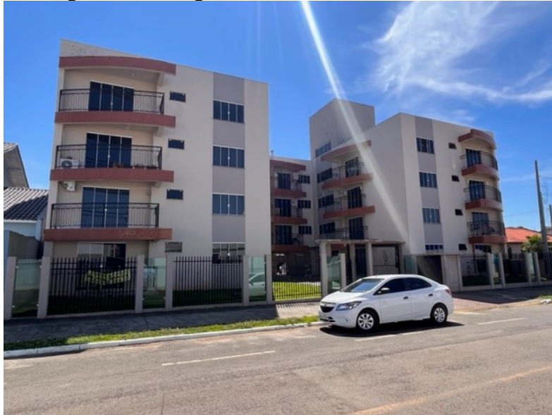
Foto 1: vista frontal do prédio.
