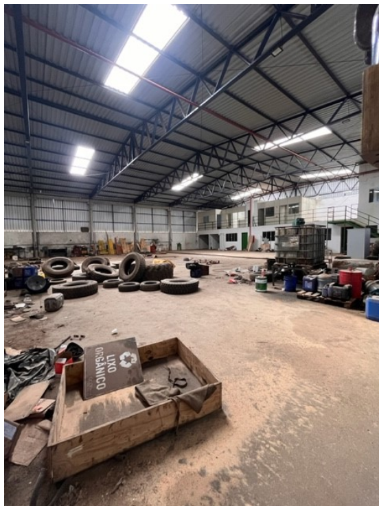
Foto 6: imagem interna do barracão.
