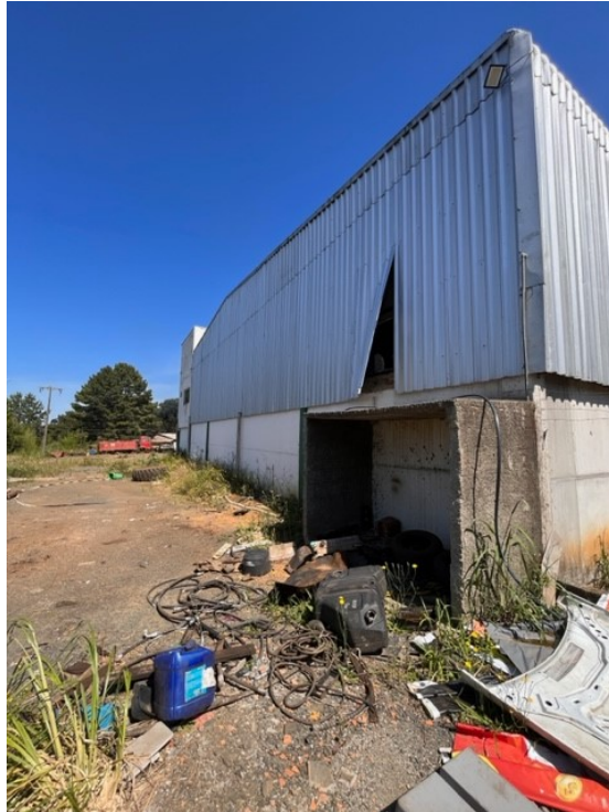
Foto 3: imagem lateral sul do barracão.
