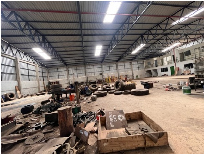
Foto 7: imagem interna do barracão.
