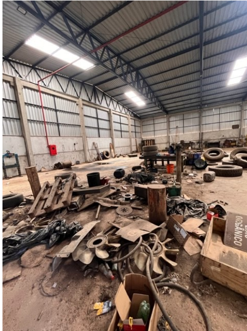
Foto 5: imagem interna do barracão.
